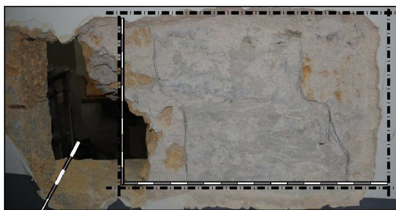
Nota: malta scarsamente coesa con giunti erosi
