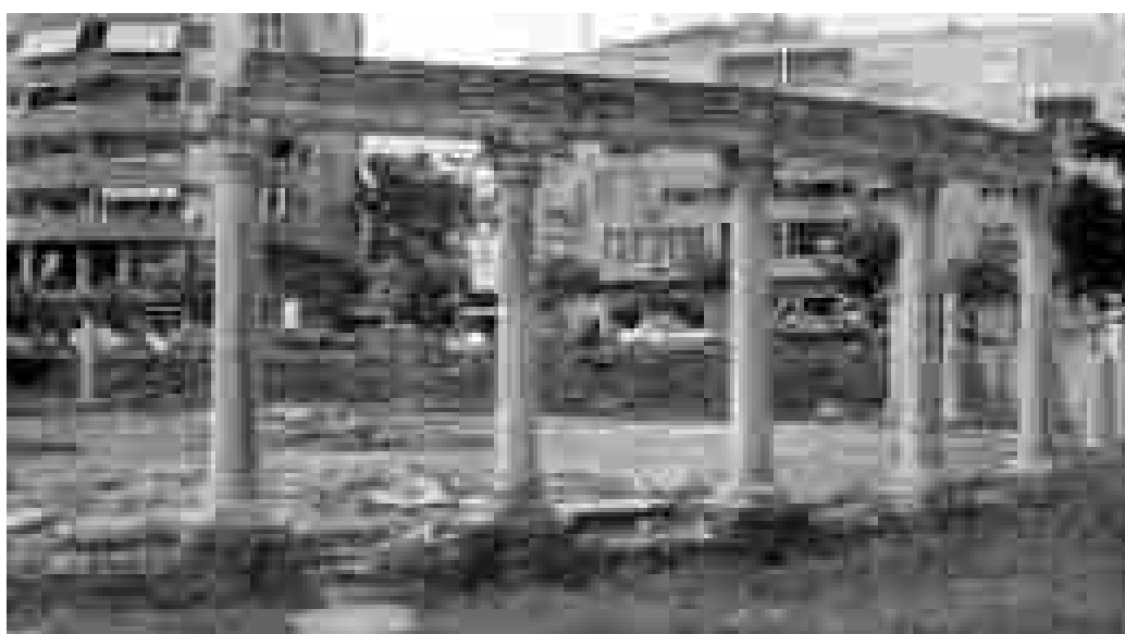
Fig. 5.4.14: Macellum-forum. Il settore Nord-Est del colonnato ricostruito nel 2003 con l'utilizzo di elementi originali e l'inserimento di una trabeazione in cemento armato (foto P. Baronio).
