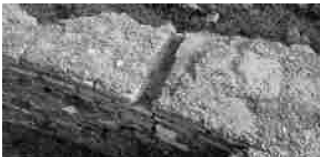
Fig. 5.4.8: Macellum-forum , vano VI. Buca pontaiia passante realizzata nel muro perimetrale esterno dell'ambiente (foto P. Baronio).
