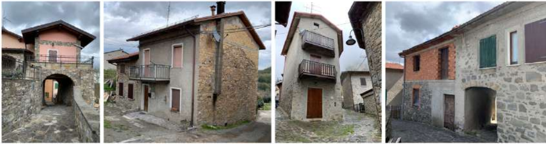
Fig. 4.17. Edifici molto trasformati a Sologno (a sinistra) e a Nismozza (a destra).
