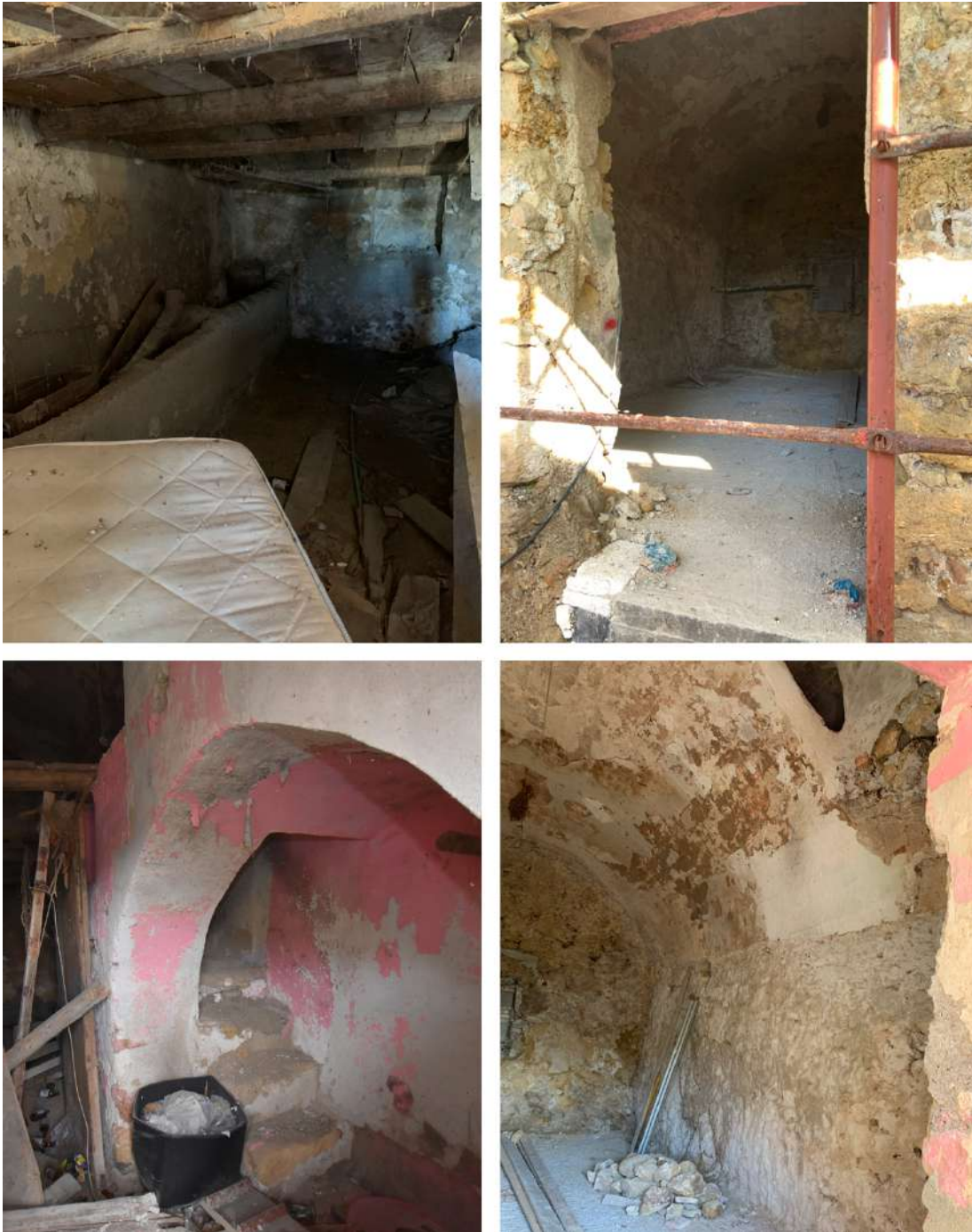
Fig. 3.21. Intervento in corso lungo la via Carlino. Il confronto tra la situazione originaria e quella attuale mostra la demolizione del soppalco ligneo, della mangiatoia e della scala.
