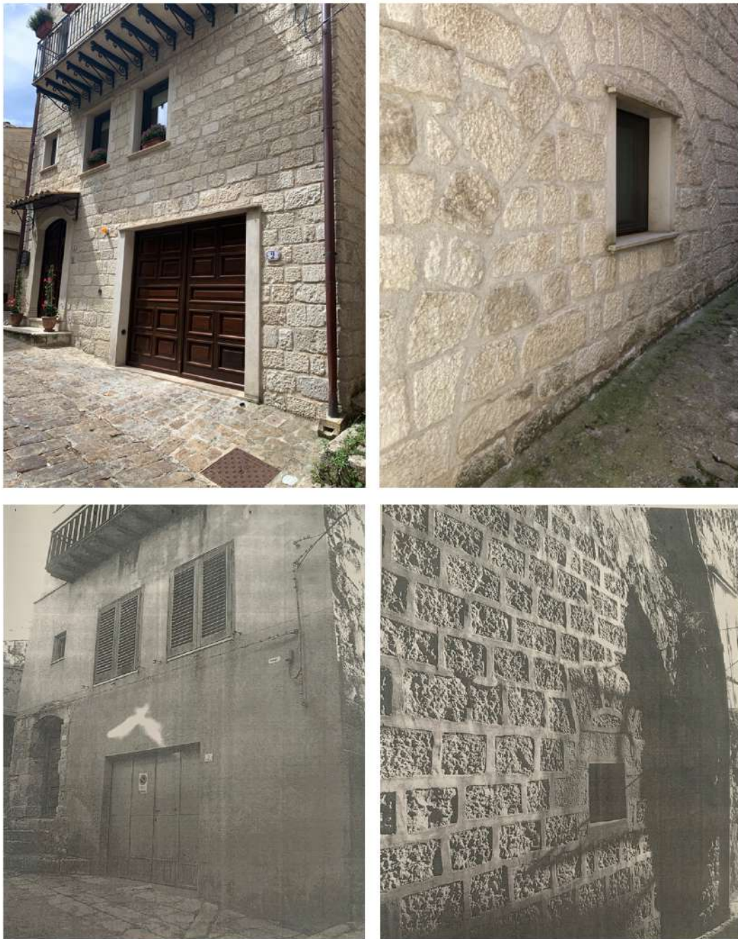
Fig. 4.12. Esempio di recente intervento di ripristino filologico in due edifici identificati come “casa a schiera ampliata”. Confronto tra la situazione attuale e quella precedente (fonte Archivio comunale). Il risultato è un intervento che, pur consentendo il riuso abitativo, privilegia un’immagine pittoresca del centro storico e non i suoi valori intrinseci.
