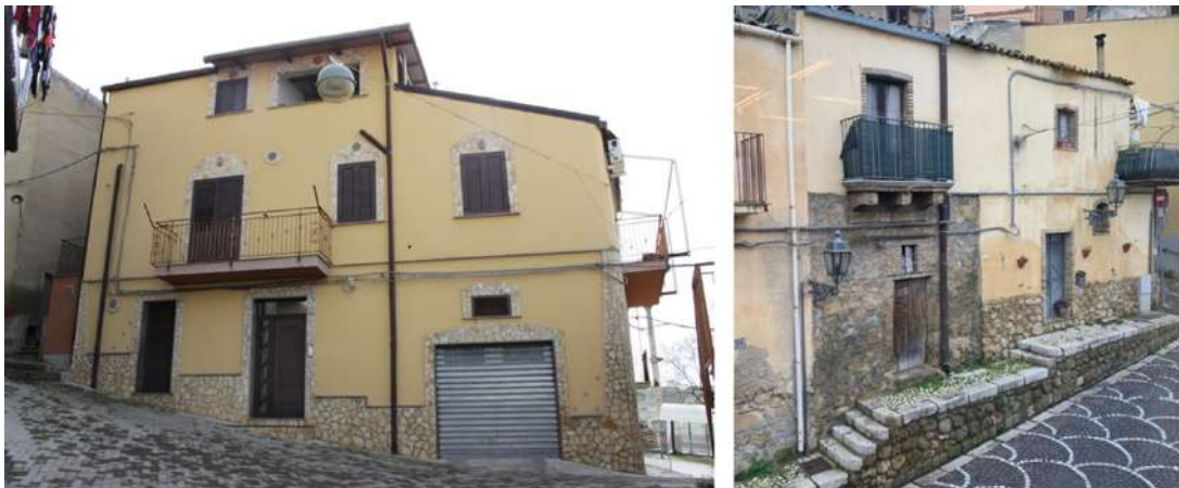
Fig. 3.29. Esempi di rifusione parziale con esclusione dei livelli a valle lungo la via Sparterra (a sinistra) e via Granfonte (a destra). L'apertura di garage di via Sparterra è frutto di una trasformazione abbastanza recente (post 1997).
