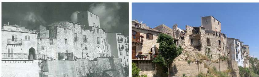
Fig 4.10. Avanzamento della ruderizzazione attraverso il confronto tra una foto storica (da BOSCARINO et al. 1994) e una attuale. Tali edifici erano segnalati in condizioni di cattivo stato di conservazione nella mappatura degli anni Novanta.
