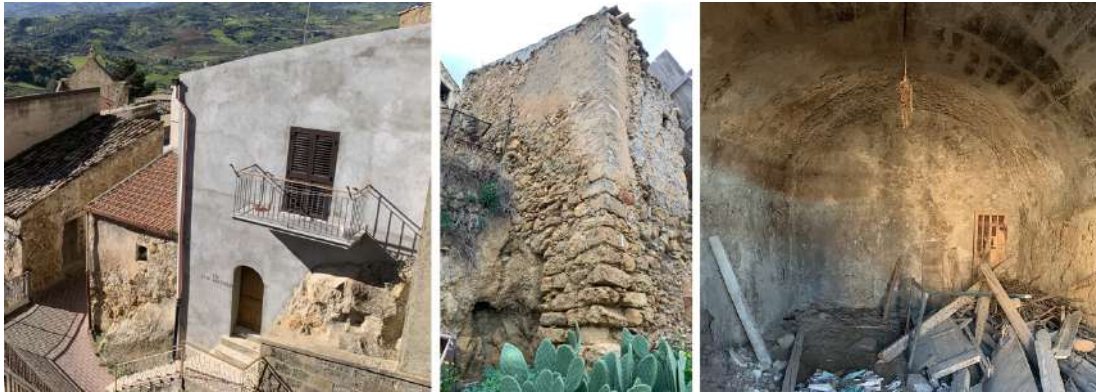
Fig. 3.10. Esempi di costruzioni del quartiere in addossamento al pendio roccioso. Le volte, come nel caso mostrato in figura, possono presentare una parte direttamente scavata nel costone roccioso.
