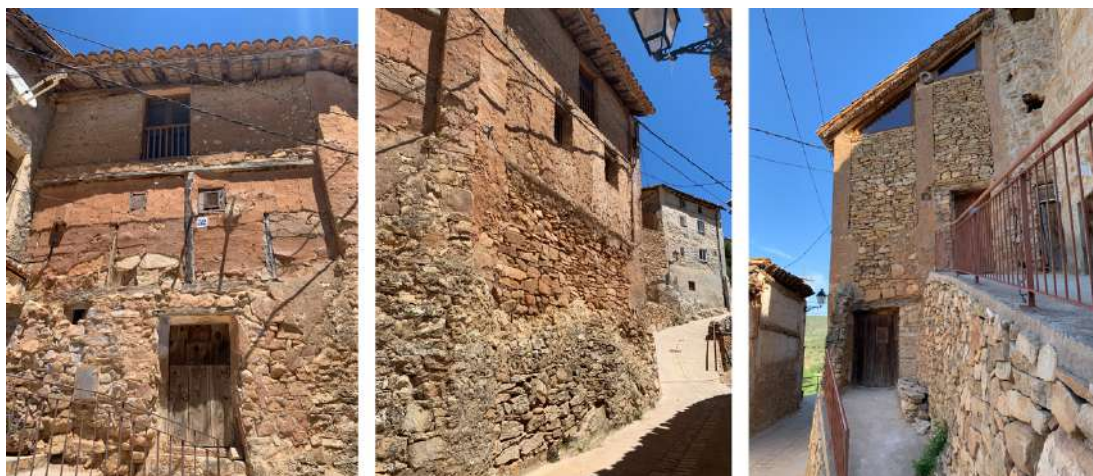
Fig. 4.40. Prospetto esterno dell'edificio in seguito al restauro.
