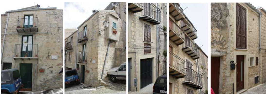
Fig. 4.1. Modalità d'intervento differenti in immobili venduti nel quadro dell'iniziativa case a un euro e oggetto di recenti interventi edilizio. La coesistenza di approcci più o meno conservativi alle finiture scaturisce dall'assenza di un sistema strutturato di linee guida sull'intervento nei prospetti. Dopo la prima vendita nel 2001, il progetto è stato particolarmente apprezzato tanto che, su un totale di 560 case abbandonate censite, quelle vendute e ristrutturate nel 2021 sono pari 180 15 .
