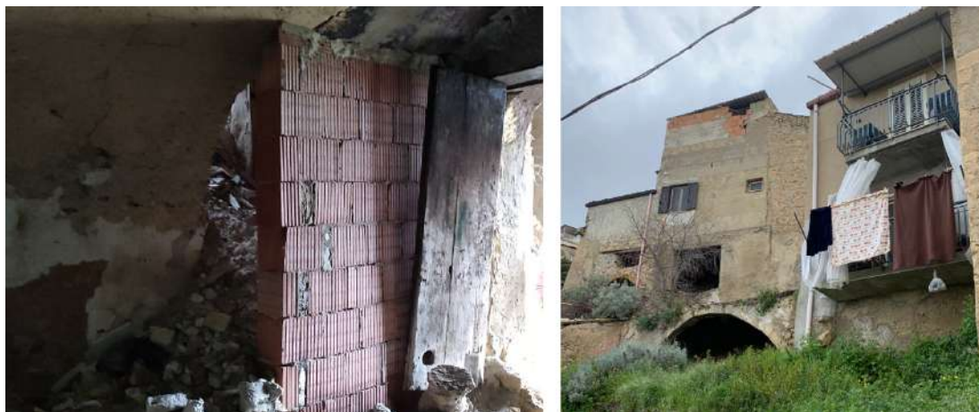
Fig. 3.31. Esempio di operazione di consolidamento di ambiente voltato a livello inferiore. Le vulnerabilità dei piani superiori derivano anche dalla presenza di una sopraelevazione precaria.
