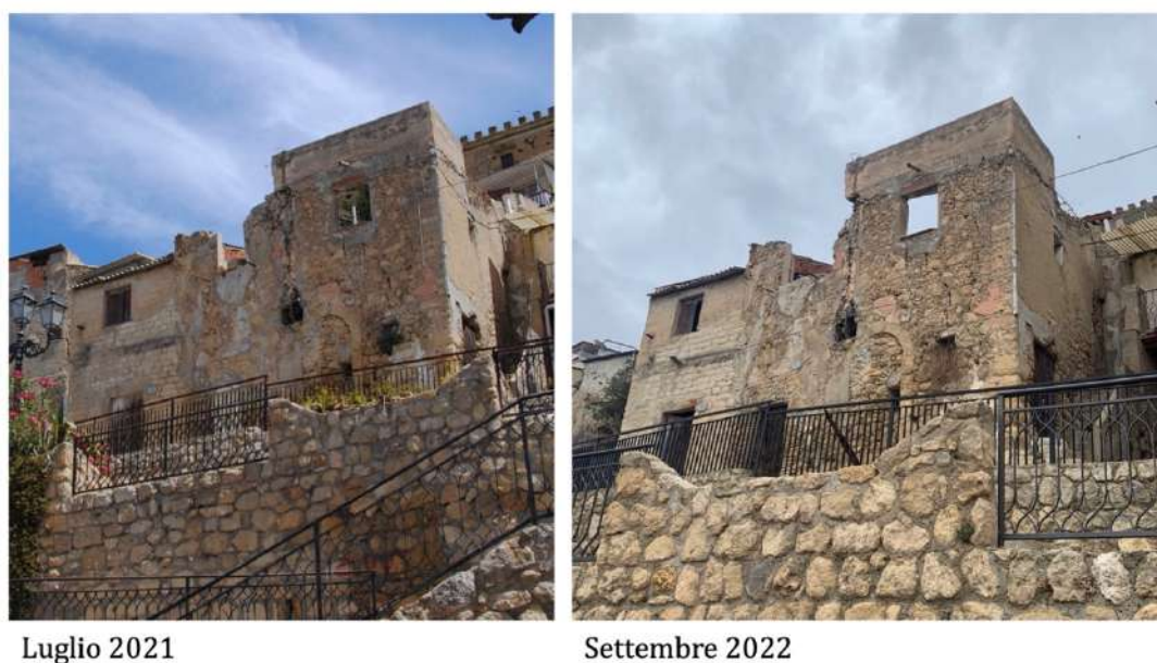
Fig. 3.44. Avanzamento dei crolli della parete di facciata di un'unità edilizia già in stato di rudere.
