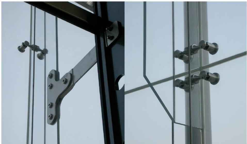
Fig. 2.11 Facciata continua a fissaggio puntuale.
