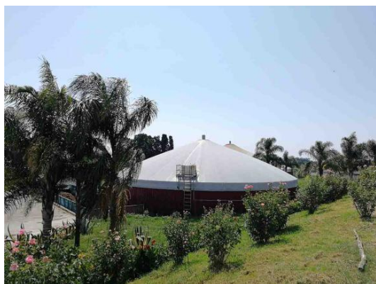
Figure 74. Fermenters of the biogas plant of Fattoria della Piana. © Y. OU (2018)
