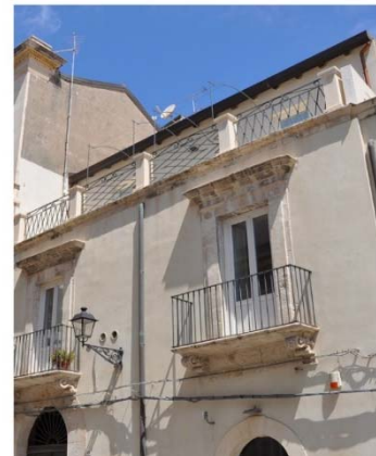
Figura 51 Esempificazione fotografica degli elementi localizzati sulla mappa delle vulnerabilità e resistenze: corpi svettanti (sx), sopraelevazioni parziali (dx).
