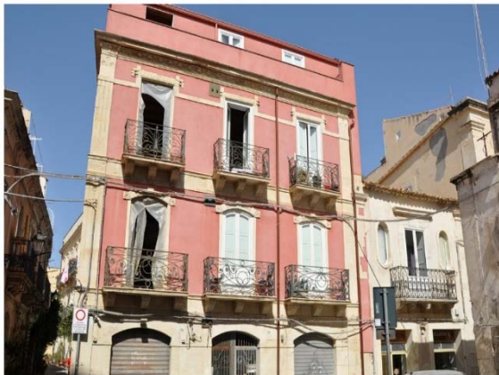
Figura 51 Esempificazione fotografica degli elementi localizzati sulla mappa delle vulnerabilità e resistenze: corpi svettanti (sx), sopraelevazioni parziali (dx).
