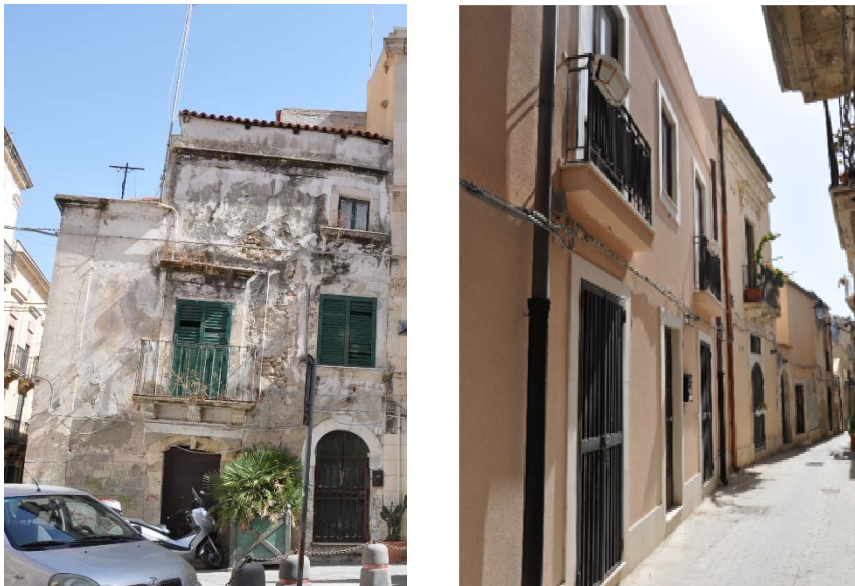
Figura 57 Casa a schiera (ISO.60) con fronte strada a tre aperture(sx) e con due aperture(dx).
