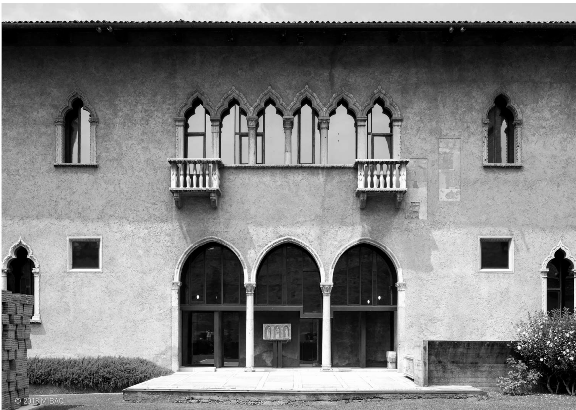
Fig. 9. Il Museo di Castelvecchio, progettato da Carlo Scarpa nel 1956 nella sede di un castello medievale che era già stato sottoposto a rimaneggiamenti nei secoli precedenti, offre una dimensione culturale, oltre che nella collezione che tutela, anche nel racconto dell'edificio che lo ospita e del progetto scarpiano, immaginato per mettere in evidenza la presenza, nel castello, di nuclei distinti appartenenti ad epoche differenti.
