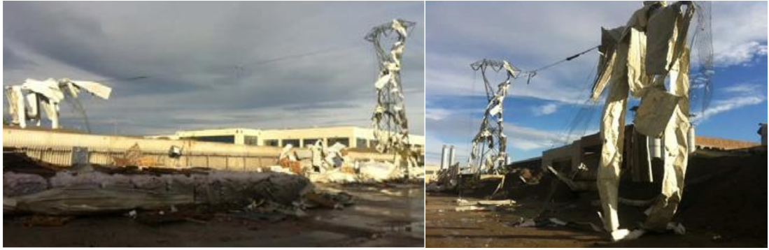
Fig. 25 Guasto alla linea 380kV dovuto alla tromba d'aria di Trezzo d'Adda del 29/07/2013
