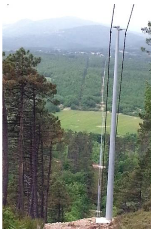
Fig. 40 Conduzione elettrica con fascia asservimento
