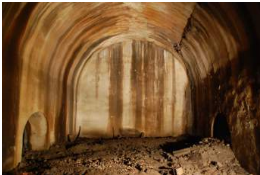
97. Cisternone sotto Parco Barberini, veduta dell'interno di uno degli ambienti
