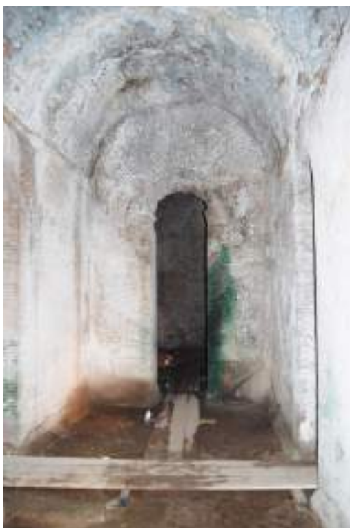
50. Palestrina, Villa Imperiale. Una delle concamerazioni della sostruzione del nucleo D
