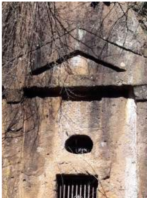
116. Parte superiore del prospetto della Chiesa rupestre di S. Spirito con in evidenza gli elementi principali della decorazione
