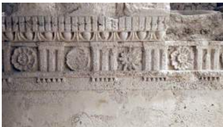
1. Particolare della decorazione a fregio dorico del podio dell'Aula Absidata, seconda metà II secolo a.C. Palestrina, Complesso degli Edifici del Foro
