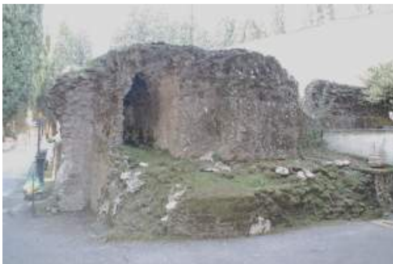
48. Palestrina, Cimitero Comunale. Panoramica del castellum aquae con in evidenza il cunicolo di distribuzione
