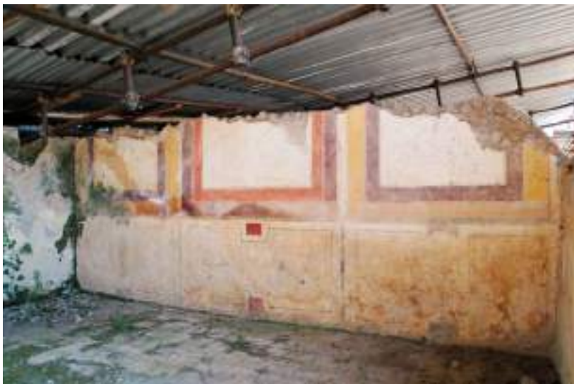
42. Palestrina, cd. Domus della Città Bassa. Particolare della decorazione pittorica di uno degli ambienti di fondo del peristilio
