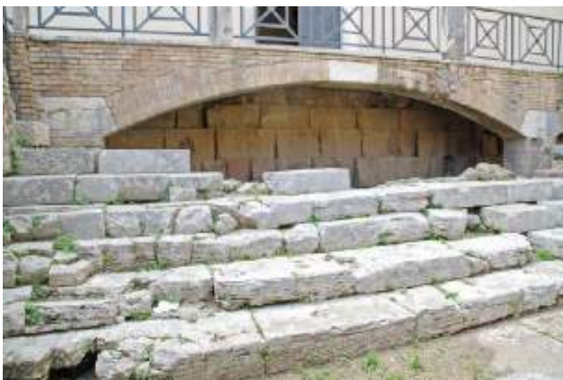
15. P.zza Regina Margherita, gradinata del tempio di Giove. In evidenza gli interventi di restauro in travertino
