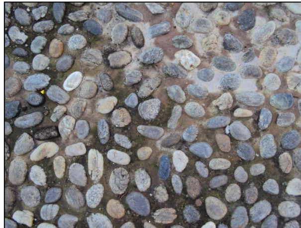
Figura 2.5. Particolare della superficie in calcestruzzo e ciottoli.
