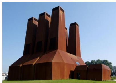
Dissonanza: nel paesaggio agricolo | Centrale di trasformazione elettrica [Fonte: www.archello.com ]
