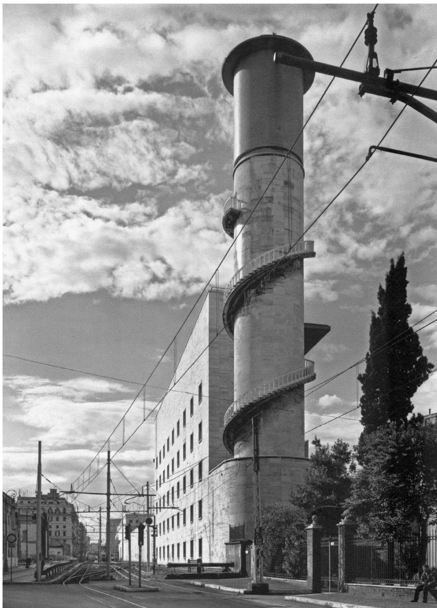
Angiolo Mazzoni, Torre idrica alla Stazione Termini. [Fonte: Casabella , n.733, maggio 2005]
