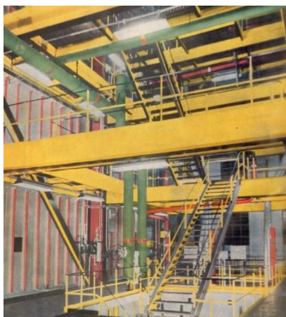
G. Passanti, G. L. Montalcini, P. Ceresa, Centrale termoelettrica S.I.P. a Chivasso, 1954 [Fonte: Domus , n.294, maggio 1954]
