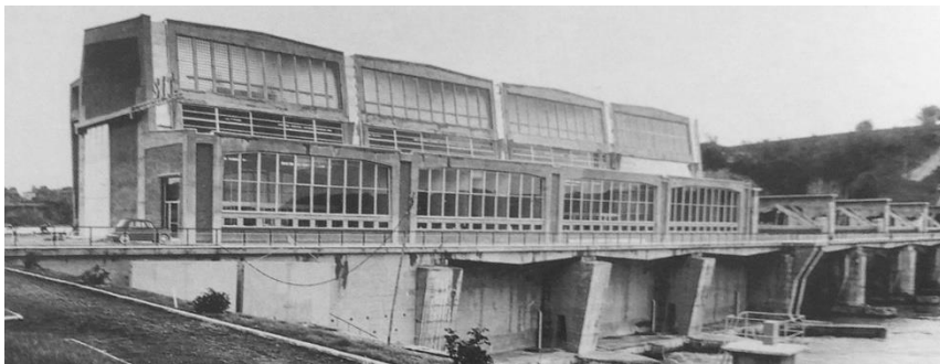
Gaetano Minnucci, Centrale elettrica a Castel Giubileo, Roma, 1948-50.
