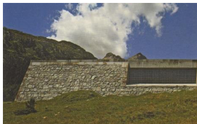
Sintonia: nel paesaggio naturale | Hans-Jörg Ruch, Stazione di commutazione elettrica di Alabanatscha (Svizzera), 2013 [Fonte: Casabella , n.823, marzo 2013]
