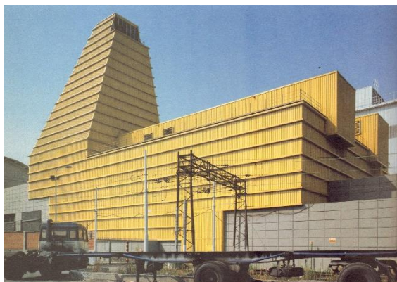
Gregotti Associati, Centrale di teleriscaldamento a Sampierdarena, 1988.
