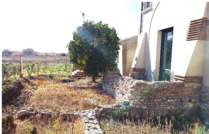
Tracce delle terme romane al di sopra delle quali sorge il Casino Macrì
