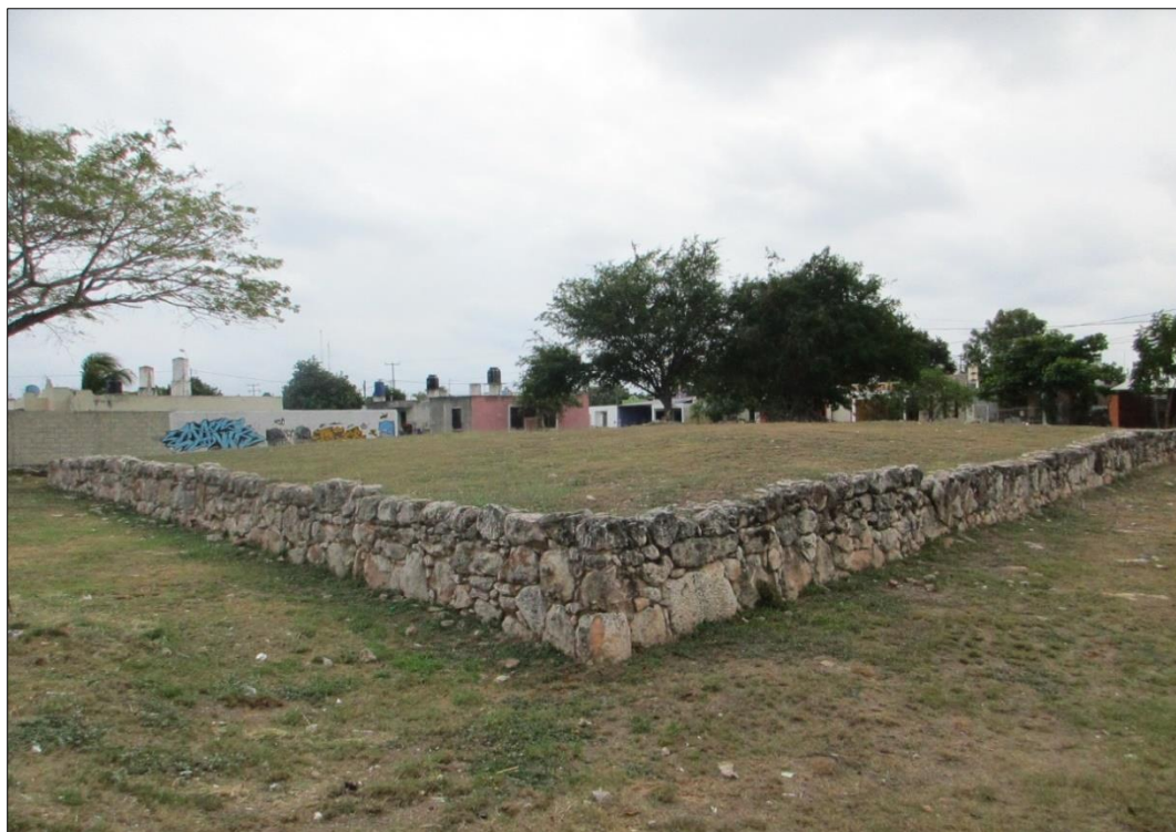
Figura 65 Piattaforma restaurata nel fracc. Juan Pablo II
