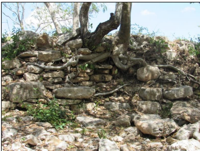
Figura 55 Dettaglio del paramento murario visibile oggi in S3, foto dell'autrice
