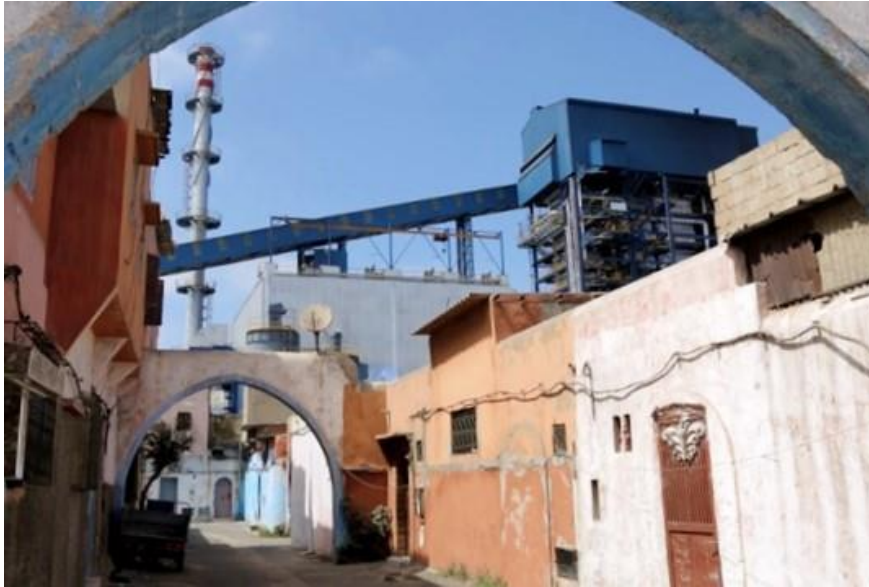
Fig. 11 Vista di una stradina della cité COSUMAR. Sullo sfondo l'adiacente fabbrica.
