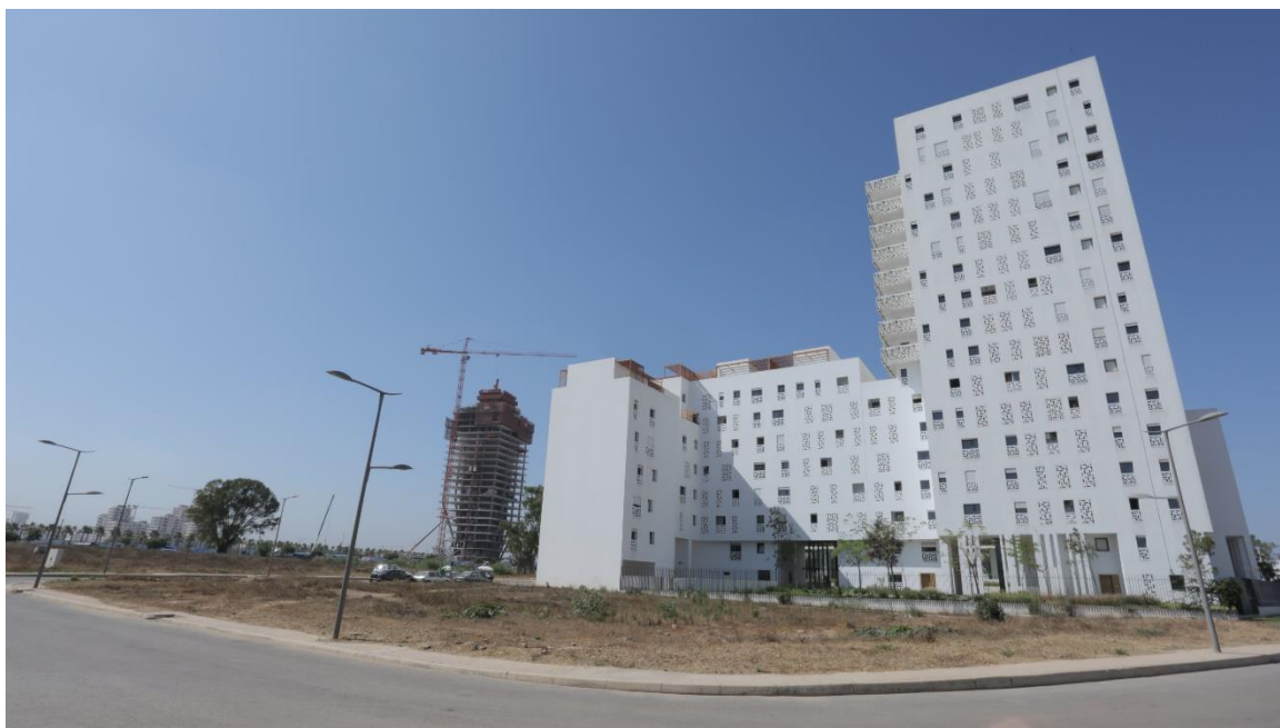
Fig. 28 Quartiere residenziale Casa Anfa, sullo sfondo la torre della CFC in costruzione – foto luglio 2017
