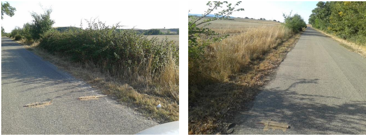
Figura 5-20. Posizionamento dei markers di riferimento per l'allineamento dei segnali accelerometrici
