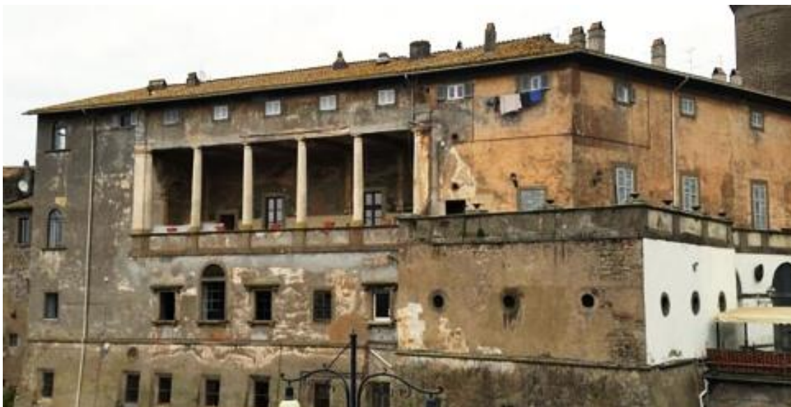
76. Bagnai, palazzo della Loggia;
