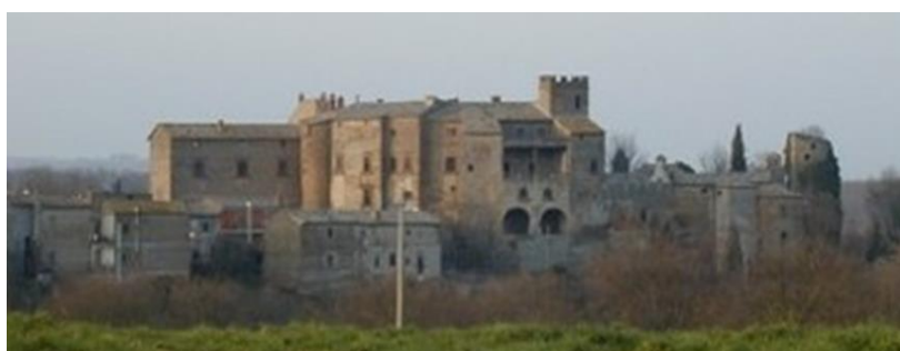
87 – 88. Montecalvello, Palazzo Monnaldeschi, vedute del complesso da Nord e Sud
