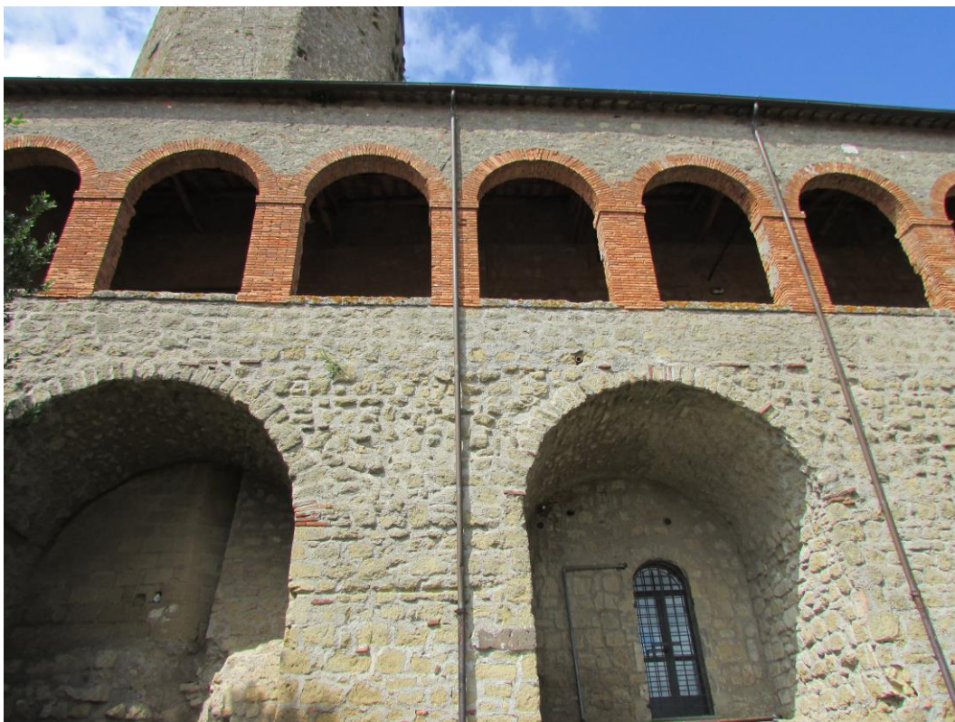
109. Valentano, palazzo Farnese, particolare della loggia sul prospetto sud;
