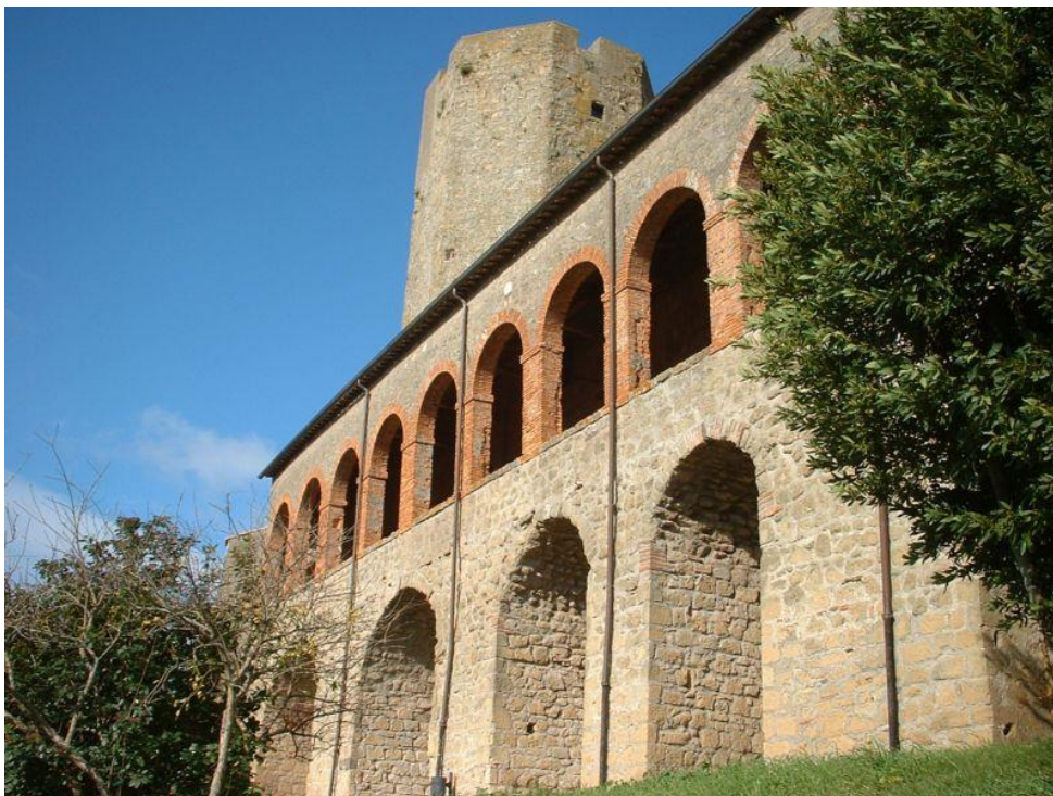
108. Valentano, palazzo Franese, loggia sul prospetto sud;
