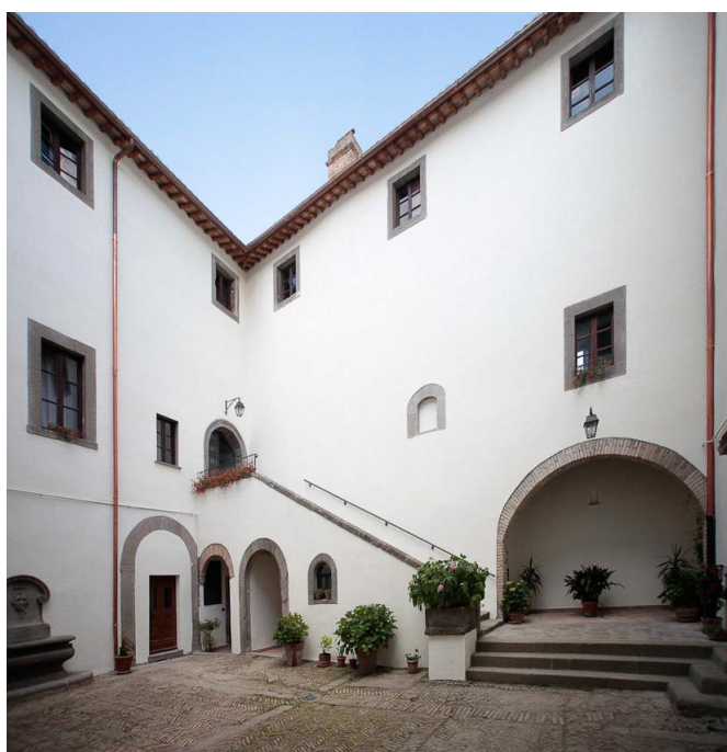
84 – 85. Mugnano in Teverina, Palazzo Orsini, facciata principale e cortile interno;
