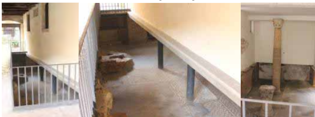
Foto dell'asola nel pavimento del vestibolo che consente di vedere il pavimento a mosaico della basilica del VI secolo. Al centro: dettaglio della trave in cemento armato sostenuta da pilastri metallici che sostiene in muro del chiostro. A sinistra: ambiente laterale al vestibolo in cui sono stati ricollocati alcuni frammenti originali del colonnato che separava la navata centrale e destra. Il solaio soprastante è stato demolito e ricostruito in cemento armato a una quota superiore.
