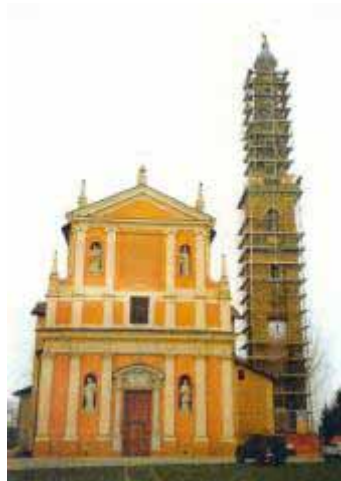
Villa Sessa (RE), campanile della chiesa di S. Maria Assunta, soggetto a forti tensioni a causa anche della preesistente inclinazione. Consolidamento mediante precompressione che ha migliorato il comportamento del campanile in caso di sisma.
