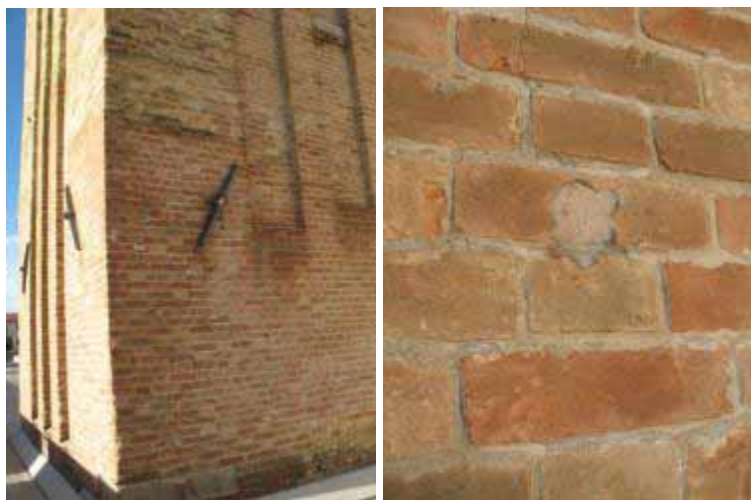
Concordia Sagittaria (VE): campanile della cattedrale di S. Stefano. Dettaglio della base del campanile e di un foro di iniezione con la stuccatura di riempimento e chiusura del foro.
