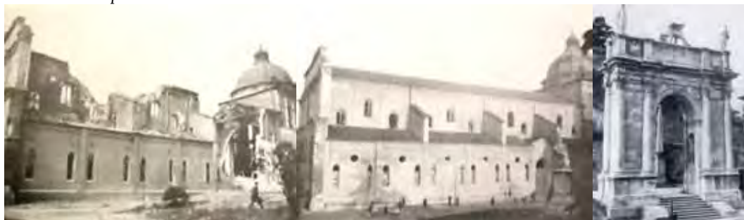
A sinistra e al centro: Vicenza, il Duomo dopo il bombardamento del 1944 e dopo i lavori di restauro in cui furono ricostruite la copertura, le volte e le murature della navata. A destra: Vicenza, arco delle Scalette ricomposto con il materiale recuperato dalla macerie; le parti nuove sono contraddistinte dall'incisione della data della ricostruzione e da una lavorazione superficiale diversa dagli elementi antichi.
