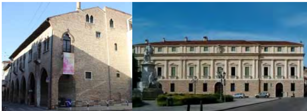
A sinistra: Treviso, la casa “da Noal” ricostruita dopo il bombardamento del 1945. A destra: Vicenza, il palazzo vescovile ricostruito dopo i bombardamenti, aggiungendo il piano attico.
