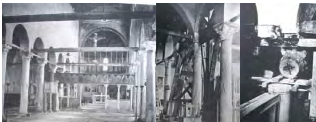
Foto della navata centrale dopo il restauro. Al centro e a destra: fasi di rimozione di un capitello per il rinforzo con un nucleo interno in bronzo (in F. FORLATI, L'architettura a Torcello , cit. figg. 59, 68, 69).
