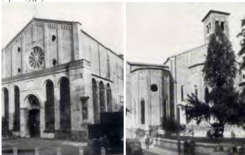
Veduta della facciata e dell'abside dopo la ricostruzione. (in F. FORLATI, op. cit., figg. 3,4).
