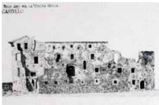
Castello di Gorizia, prospetto est: rilievo dello stato di fatto dopo le distruzioni belliche, eseguito dalla Soprintendenza nei primi anni venti (originale in SABAP-FVG, pubblicato in L. TOMASI, La selezione dei beni culturali: il restauro del castello di Gorizia , Gorizia 1985, p. 88). Rilievo dello stato di fatto del mastio e della cinta muraria dopo le distruzioni belliche, eseguito dalla Soprintendenza nei primi anni venti (originale in SABAP-FVG, pubblicato in L. TOMASI, op. cit. , p. 92).
