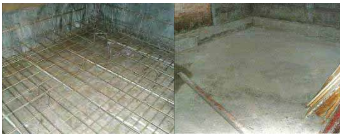
A sinistra: posa in opera delle armature delle vasche in acciaio inossidabile. A destra: vasca ultimata di cui si può notare il risvolto verticale sulle pareti perimetrali dell'ambiente (in C. MENICHELLI, op. cit., figg. 3-4).
