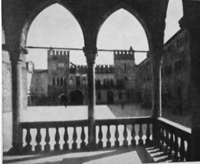
Capodistria, la loggia dopo il restauro in cui furono consolidati i capitelli con nuclei interni portanti in cemento armato. Il restauro comportò la liberazione delle arcate dalle vetrare che le occludevano. (in F. Forlati, L'arte moderna e la tecnica d'oggi nel restauro monumentale, 1940, fig. 6).
