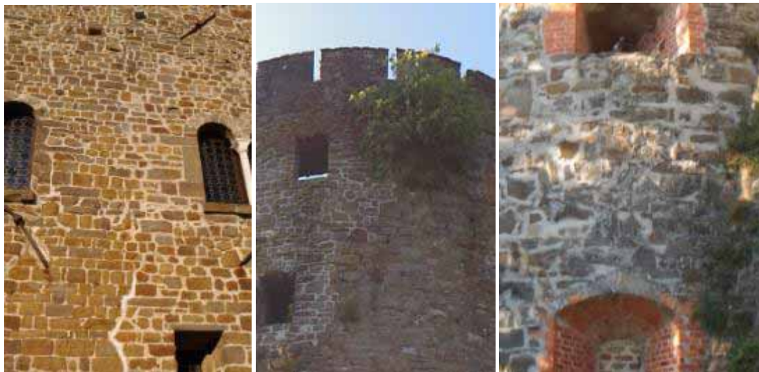
Castello di Gorizia. Alcuni dettagli dei paramenti murari a vista: si può notare la presenza di diversi tipi murari.
