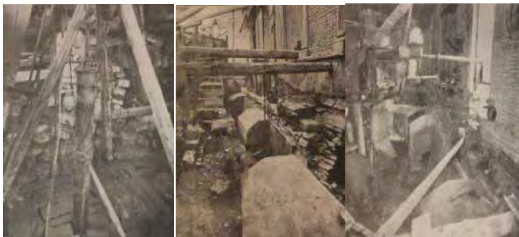
A sinistra: “tubo di forma” per la realizzazione dei pali tipo C.C.C.. Al centro e a destra: dettaglio dei rinforzi in cemento armato. Si possono notare i blocchi di collegamento tra le teste dei pali e la fondazione sul lato esterno e interno del palazzo dei Camerlenghi.
