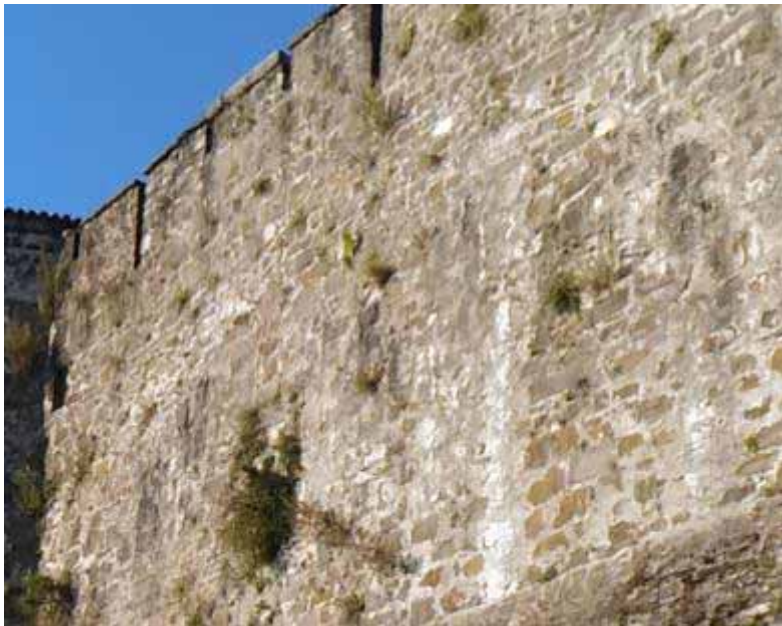
Castello di Gorizia. Lacerti di finiture murarie di epoca indeterminata sulla cinta interna che potrebbero restituire alcune informazioni sulle tecniche costruttive del complesso.
