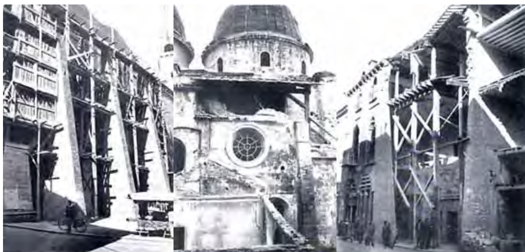
A sinistra: Treviso, Palazzo dei Trecento. Contrafforti sostegno dei muri di testata. Al centro: Treviso, Duomo, cappella dell'Annunziata. Opere di protezione dalle intemperie. A destra: Vicenza, palazzo Baschi-Brunello. Puntellature e contrafforti provvisori di sostegno delle strutture superstiti della facciata, della copertura e dei solai.
