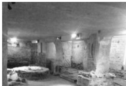
Finalmarina (SV), pieve. Solaio in cemento armato realizzato negli anni quaranta nell'area archeologica sottostante l'edificio.
