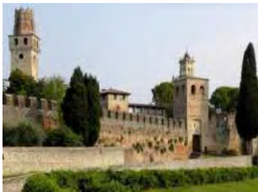
Foto attuale del muro di cinta. Sul retro l'edificio della Cancelleria.
