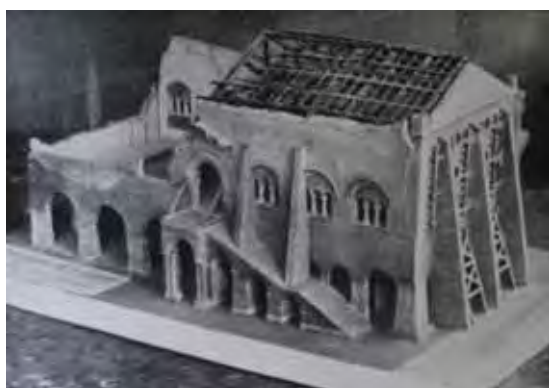
Modello del palazzo dei Trecento di Treviso, realizzato all'epoca del restauro di Forlati, in cui si possono vedere i contrafforti per la messa in sicurezza delle pareti fuoripiombo e i dispositivi per il loro raddrizzamento.
