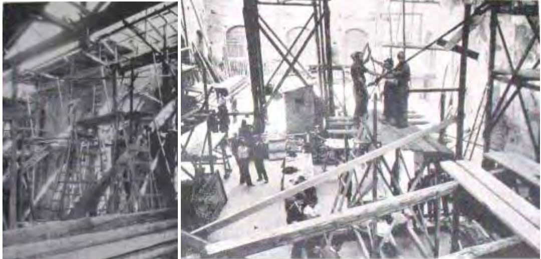
A sinistra: Opere di preparazione del lato interno del muro da raddrizzare. A destra: operai che applicano la forza per la rotazione del muro settentrionale tramite una barra in ferro inserita nel tenditore del tirante. (in F. FORLATI, op. cit., figg. 43, 48).
