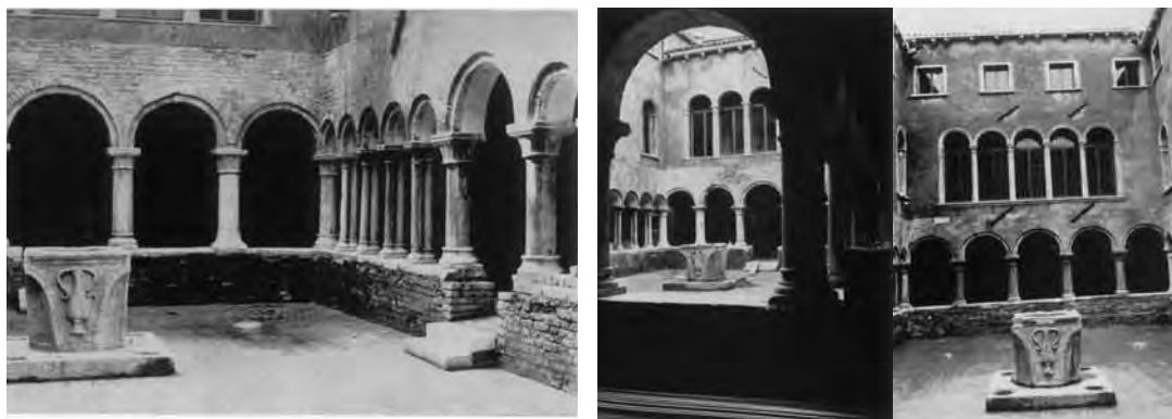
Foto del chiostro al termine dei lavori: si può notare la sistemazione finale del complesso con l'abbassamento della quota del cortile, i gradini di raccordo, la liberazione delle aperture dai tamponamenti. Nella foto di sinistra si evidenzia il trattamento del prospetto al piano terra con paramento a vista, differenziato dalla parte superiore a intonaco: si presume che l'intervento volesse evidenziare le diverse fasi costruttive (in F. FORLATI, Il restauro del chiostro di S. Apollonia , cit., figg. 3, 4, 6, 7, 8).
