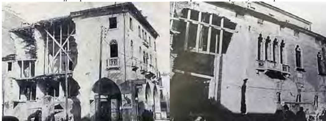
A sinistra: Treviso, casa in via Collalto 2. Puntellamenti di solai e copertura. A destra: Padova, casa Locatello, via Altinate. Tamponamento delle arcate al piano terra, contrafforti in facciata e puntelli nella copertura.
