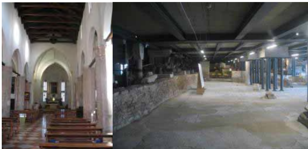
Concordia Sagittaria, cattedrale di S. Stefano. A sinistra: veduta della navata centrale. A destra: corrispondente punto di ripresa nell'area archeologica sottostante: il gruppo di pilastri sulla destra della foto sostiene il colonnato destro superiore. Il colonnato sinistro superiore è sostenuto dai pali in cemento armato a sinistra della foto, oltre il muro antico, che sono stati oggetto di un recente consolidamento.
