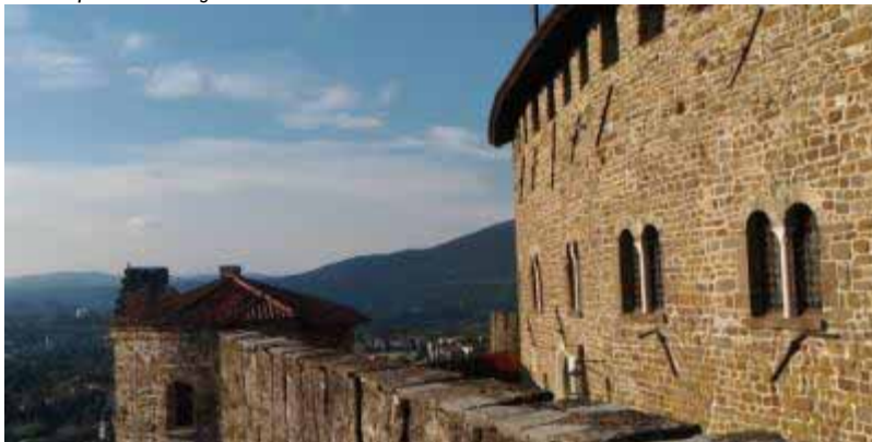
Castello di Gorizia. Alcuni dettagli dei paramenti murari a vista: si può notare la scarsa qualità esecutiva di alcune finiture dei giunti realizzati durante i restauri novecenteschi.
