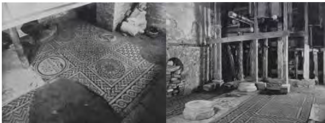
Verona, basilica paleocristiana sotto la Capitolare: mosaico della navata centrale: si può vedere un pilastro metallico di sostegno alla trave in cemento armato che sostiene il muro soprastante. A destra: Tratto delle navate destra e centrale separate dalle basi delle colonne. Sul fondo: opere provvisorie per il sostegno delle strutture durante le indagini (in B. TAMARO FORLATI, L'opera della Soprintendenza alle Antichità delle Venezia 1952-57 ).
