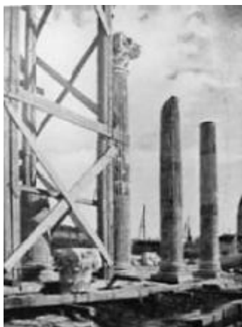
Aquileia, viale degli scavi: passeggiata archeologica che conduce dal porto fluviale alla basilica patriarcale. Il portale moderno progettato da Forlati e la sistemazione di reperti archeologici rinvenuti durante lo scavo: si possono notare le reintegrazioni in cemento prive di ornamento e gli elementi vegetali che mascherano i supporti murari della cornice (in "Aquileia Nostra", 1938, foto realizzata in occasione della visita di Mussolini ad Aquileia).
