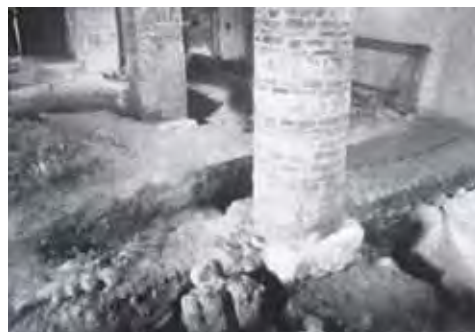
Sommacampagna (VR), pieve di S. Andrea, 1941 ca. Rilievo dello stato di fatto in cui la caratterizzazione del prospetto indica i diversi tipi murari e le tracce di aperture tamponate. A destra: indagini nel sottosuolo all'interno dell'edificio (in F. FORLATI, La pieve di S. Andrea di Sommacampagna , cit., figg. 7, 19).
