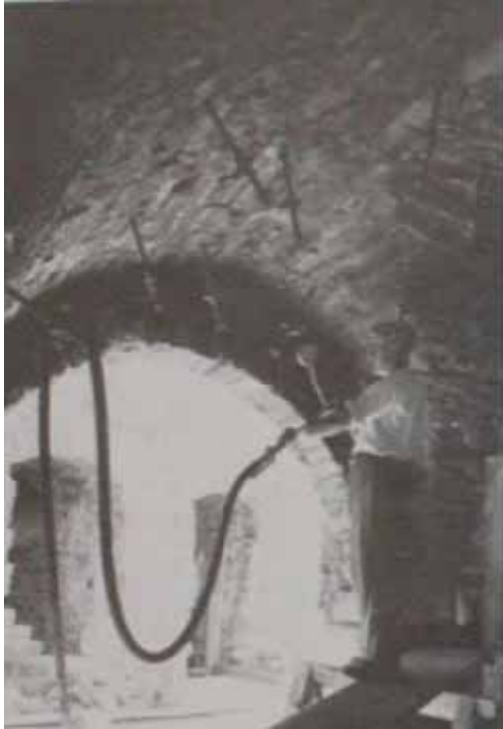
Fotografia che documenta le iniezioni di miscele consolidanti in una volta del castello: si possono notare i tubi metallici inseriti nella muratura e il tubo con manometro collegato alla pompa di iniezione (documento degli archivi del Genio Civile, databile al 1936-7, riportata in TOMMASI, , op. cit.)
