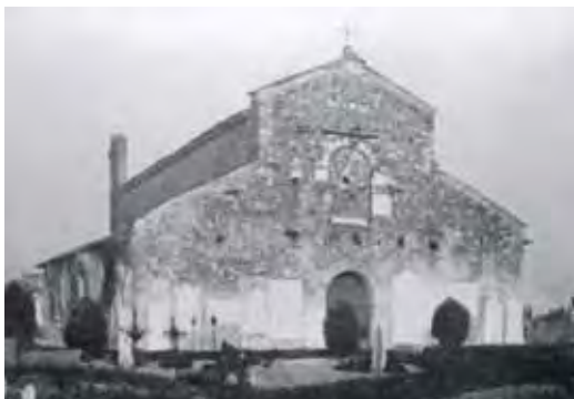
Immagini dell'abside e della facciata, prima e dopo i lavori. Si possono notare le rimozione delle lastre sui prospetti e le riprese del paramento, e la ricostruzione delle absidi minori (in F. FORLATI, La pieve di S. Andrea di Sommacampagna , cit., figg. 13, 24, 25, 26).
