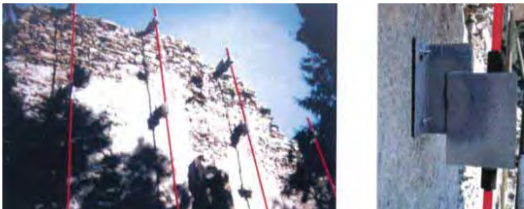
Stabilizzazione di una parete isolata mediante cavi post-tesi esterni alla struttura, ancorati con piastre in acciaio inossidabile. I cavi sono disposti su entrambi i lati del muro per fronteggiare l'azione del vento in entrambe le direzioni (in L. JURINA, Consolidamento strutturale e reversibilità , figg. 4-5)
