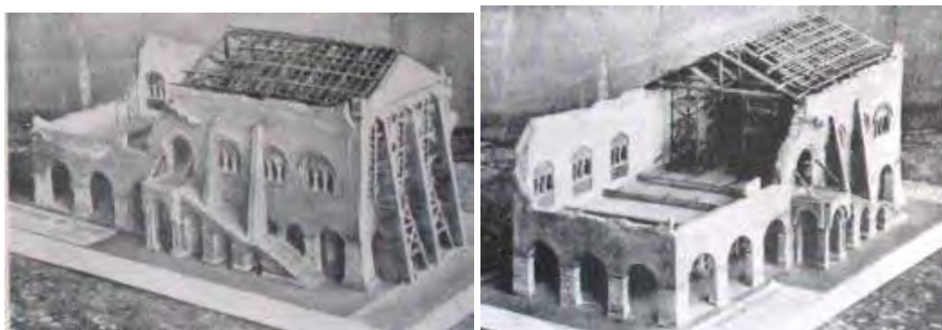
Plastico del palazzo dopo il bombardamento in cui si possono notare l'entità dei crolli, oltre ai presidi per la messa in sicurezza e i dispositivi per il recupero delle deformazioni. (in F. FORLATI, op.cit., figg. 46-47).
