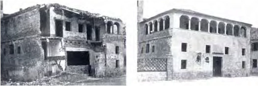
Treviso, Osteria della colonna prima e dopo il restauro. Oltre alla ricostruzione della parti danneggiate, si può notare la riapertura della loggia all'ultimo piano del prospetto laterale.
