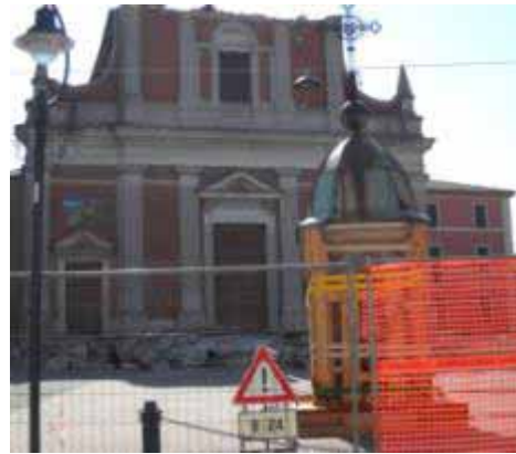
Sopra il campanile della chiesa di Mirabello (FE) privato della parte terminale, smontata e posata sul sagrato subito dopo gli eventi sismici. Interventi di somma urgenza realizzati dalle squadre speciali dei Vigili del Fuoco.
