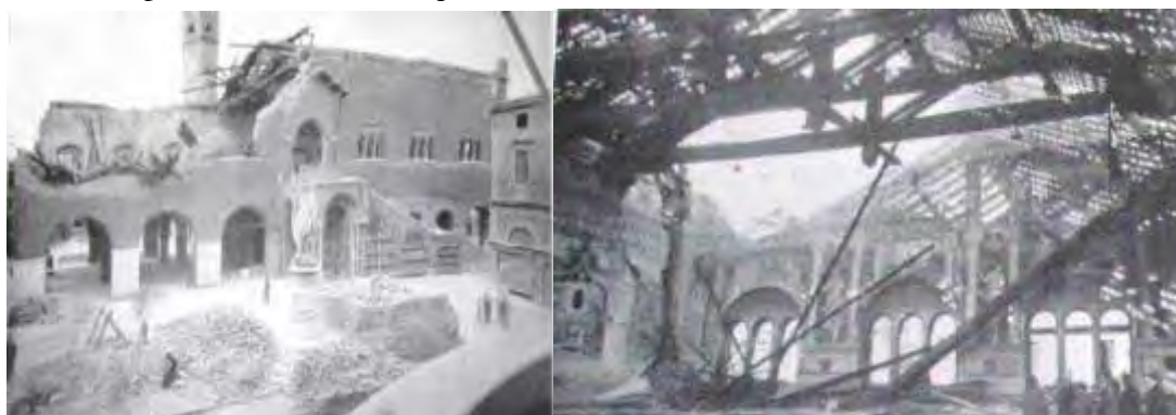
Foto dei crolli subiti a causa della bomba che colpì il palazzo nel 1944. (in C. PEROGALLI, La progettazione del restauro monumentale , Milano 1955 e F. FORLATI, op. cit. , fig. 35).
