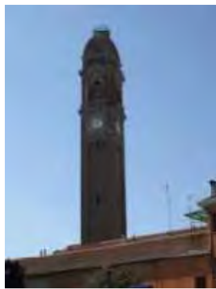
Sopra il campanile della chiesa di Mirabello (FE) privato della parte terminale, smontata e posata sul sagrato subito dopo gli eventi sismici. Interventi di somma urgenza realizzati dalle squadre speciali dei Vigili del Fuoco.
