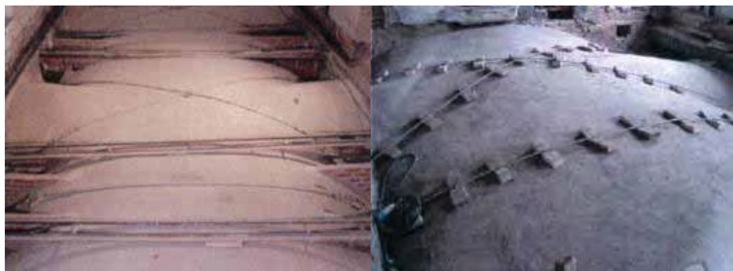
Magenta (MI), Casa Giacobbe. Nerviano (MI), monastero degli Olivetani. Volte consolidate con cavi messi in tensione mediante tenditori o cunei (L. JURINA, Consolidamento strutturale e reversibilità , cit., figg. 22, 24).
