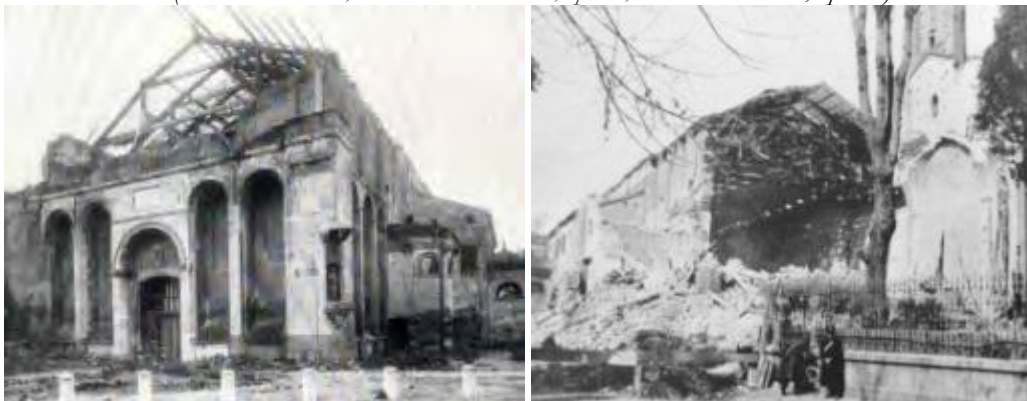
Immagini dei danni prodotti dal bombardamento aereo del 1944 sulla facciata e nell'abside. (in F. FORLATI, op. cit., fig.1)
