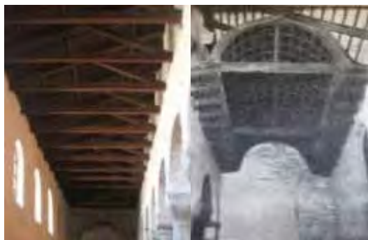
1926-30: Parenzo, basilica Eufrosiana. Ricomposizione dei soffitti delle navate laterali.
