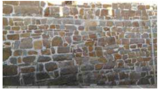
Castello di Gorizia. Alcuni dettagli dei paramenti murari a vista: si può notare la scarsa qualità esecutiva di alcune finiture dei giunti realizzati durante i restauri novecenteschi.
