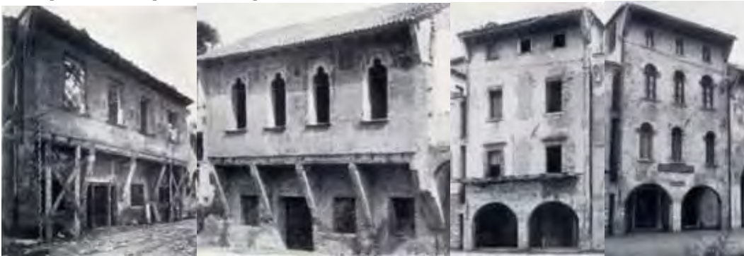
A sinistra: Treviso, casa in via Giordani 16. Si può notare il ripristino delle aperture lobate e dell'aggetto della copertura. A destra: Treviso, casa in via S. Nicolò 3. Si può notare il ripristino delle aperture sul prospetto.
