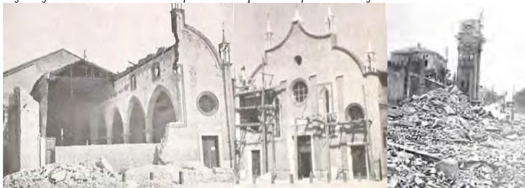
A sinistra e al centro: Treviso, chiesa di S. Maria Maggiore dopo il bombardamento del 1944 e dopo la ricostruzione della facciata e della navata sinistra con i materiali originali recuperati. A destra: Vicenza, Arco delle Scalette dopo il bombardamento del 1944 che ne distrusse oltre i due terzi.
