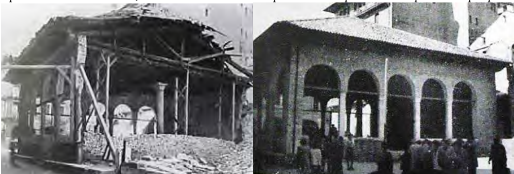
Treviso, Loggia dei Cavalieri prima e dopo il restauro in cui la parte distrutta è stata ricostruita con il materiale recuperato dalle macerie.
