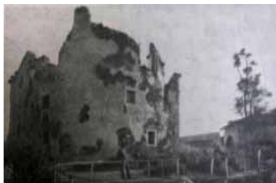
La torre semicircolare alla fine del 1918: si può notare la presenza di intonaco (publicata in M.R. COSSAR, op. cit.)
