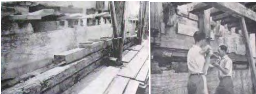
Dettagli della cerniera artificiale per predeterminare l'asse di rotazione del muro. A sinistra si possono notare gli inserti in calcestruzzo che realizzano i due piani inclinati, mantenuti separati da cunei in legno progressivamente estratti durante le operazioni di rotazione del muro fino a fare collimare le due superfici in calcestruzzo. A destra le operazioni di chiusura della cerniera. (in F. FORLATI, op. cit., figg. 45, 53).
