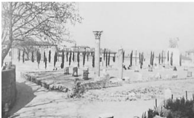
Trieste, colle di S. Giusto, "basilica romana": saggio di ricomposizione delle colonne con integrazione di materiale laterizio in una foto storica e attuale. (foto storica in Bruna Forlati Tamaro, La basilica romana di Trieste sul colle di S. Giusto , Milano, 1969, fig. 5).
