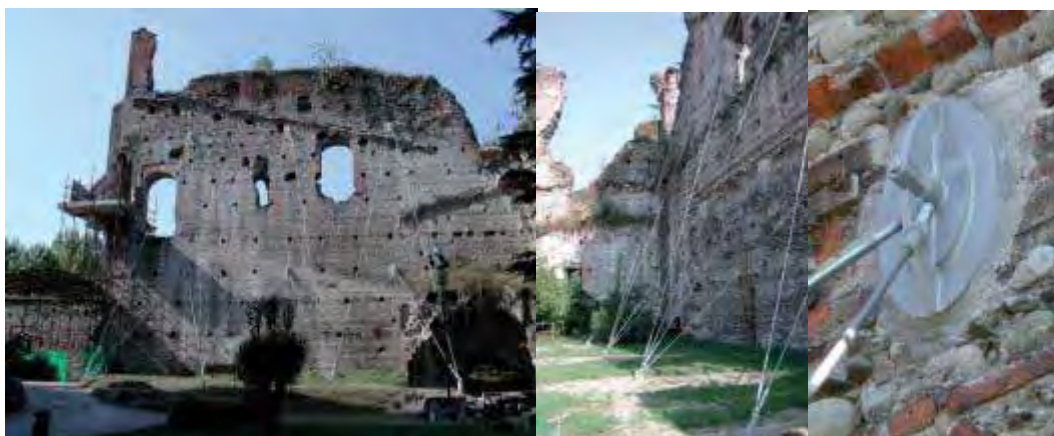
Castello di Trezzo d'Adda (MI): intervento provvisorio di stabilizzazione di un muro isolato con stralli di rinforzo costituiti da cavi in acciaio a vista, ancorati al terreno. (in L. JURINA, Vivere il monumento: conservazione e novità , Milano 2006).
