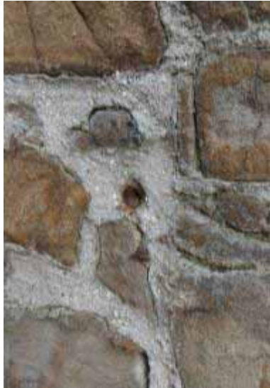
Dettaglio di un altro tubo di iniezione.
