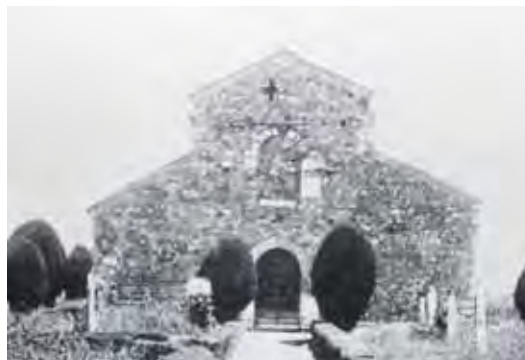
Immagini dell'abside e della facciata, prima e dopo i lavori. Si possono notare le rimozione delle lastre sui prospetti e le riprese del paramento, e la ricostruzione delle absidi minori (in F. FORLATI, La pieve di S. Andrea di Sommacampagna , cit., figg. 13, 24, 25, 26).
