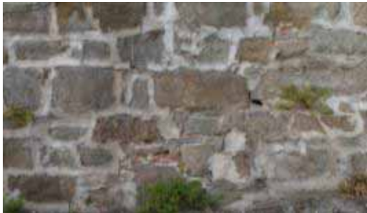
Castello di Gorizia. Alcuni dettagli dei paramenti murari a vista: si può notare la scarsa qualità esecutiva di alcune finiture dei giunti realizzati durante i restauri novecenteschi.
