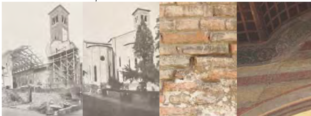
Padova, chiesa degli Eremitani dopo il bombardamento del 1944 e dopo il restauro. Al centro: dettaglio del solco che separa le murature ricostruite da quelle originali nella zona dell'abside. A destra: Dettaglio della ripresa della decorazione nelle parti ricostruite, differenziata da quella originale.
