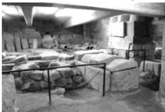
Orvieto, Chiesa di S. Andrea. Veduta recente del solaio in cemento armato del 1928 che ha consentito di lasciare visitabile l'area archeologica.
