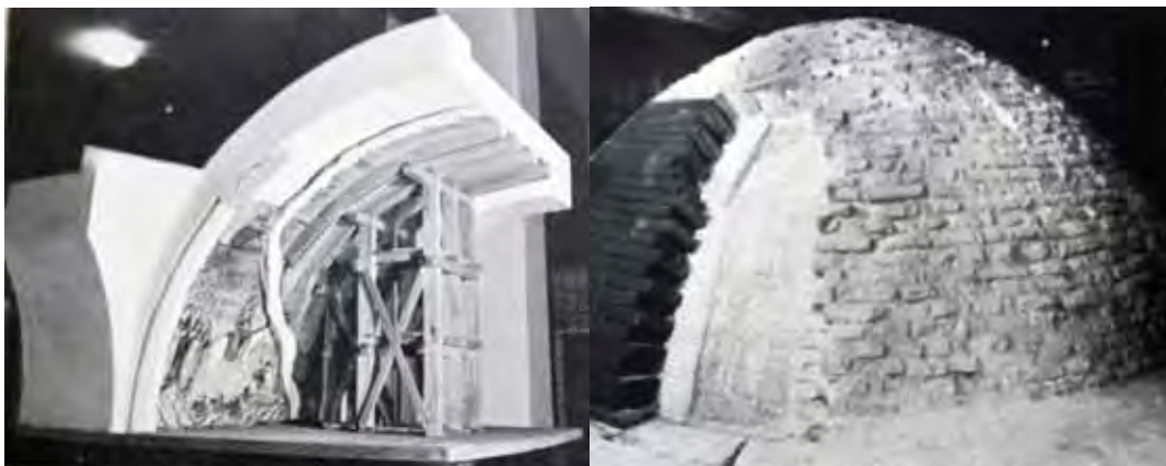
Venezia, Basilica di San Marco. Modello per il consolidamento della muratura senza staccare il mosaico di rivestimento. A destra: rifacimento della struttura di una volta dell'atrio (in F. FORLATI, La basilica di San Marco attraverso i suoi restauri , cit., pp. 152, 159).
