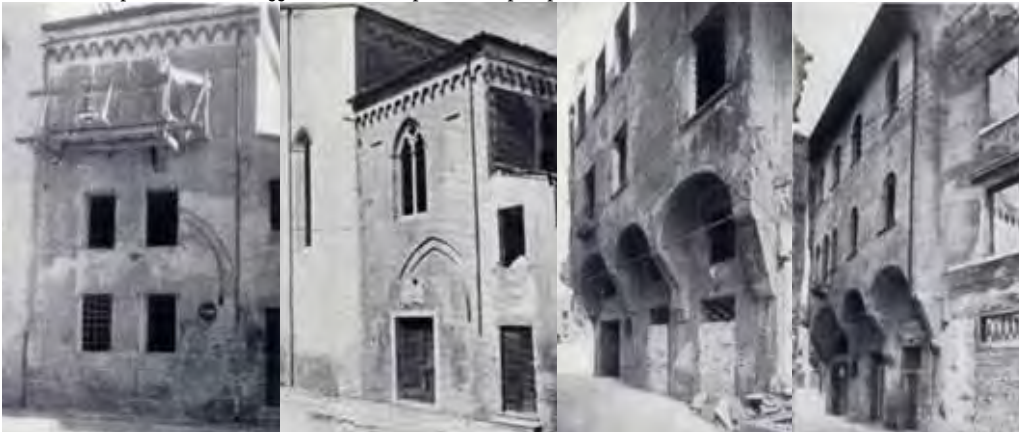
A sinistra: Treviso, cappella degli Innocenti nella chiesa di S. Caterina prima e dopo il restauro che rimosse le opere di adattamento della cappella ad abitazione: si può notare la riapertura della bifora al centro, la modifica delle altre aperture e il completamento dell'arco a sesto acuto. A destra: Treviso, Casa in vicolo Barberia n. 6-8-10. Si può notare il ripristino delle aperture ad arco.
