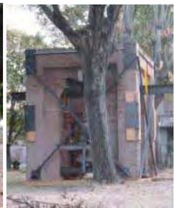
Sopra il campanile della chiesa di Mirabello (FE) privato della parte terminale, smontata e posata sul sagrato subito dopo gli eventi sismici. Interventi di somma urgenza realizzati dalle squadre speciali dei Vigili del Fuoco.
