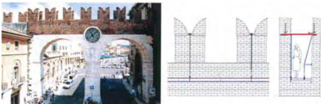
Verona, Portoni della Brà. Intervento di stabilizzazione delle merlature inclinate mediante l'applicazione di carichi esterni in grado di contrastare il momento instabilizzante. Il progetto prevedeva di posare un "bilancino" tubolare in acciaio inox tra due merli contrapposti e di appendere una zavorra a quest'ultimo, con l'accortezza che i punti di appoggio fossero eccentrici rispetto all'asse della merlatura dalla parte contraria rispetto all'inclinazione esistente. Due tiranti inox collegano la zavorra al bilancino; un tirante è parallelo alla muratura mentre l'altro ha un'inclinazione di 15^\circ e si ancora in sommità al merlo fuoripiombo; per la scomposizione della forza esso induce una forza orizzontale e una verticale, entrambe stabilizzanti (in L. JURINA, Consolidamento ... cit. , figg. 10-11).
