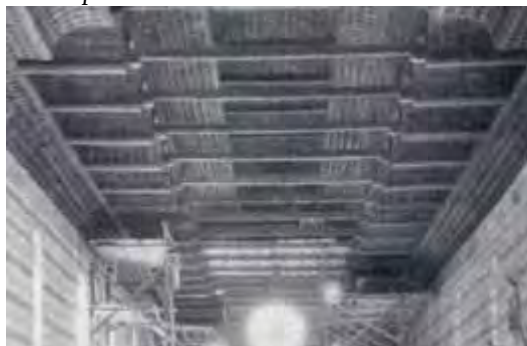
1946-48: Padova, chiesa degli Eremitani. Ricostruzione di un tratto di copertura lignea.
