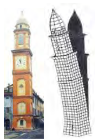
San Martino in Rio (RE), campanile della chiesa parrocchiale. Immagine del modello matematico che ha consentito di valutare il comportamento dinamico del campanile in caso di sisma, confrontando i risultati del modello con i dati desunti da un monitoraggio e da prove diagnostiche.
