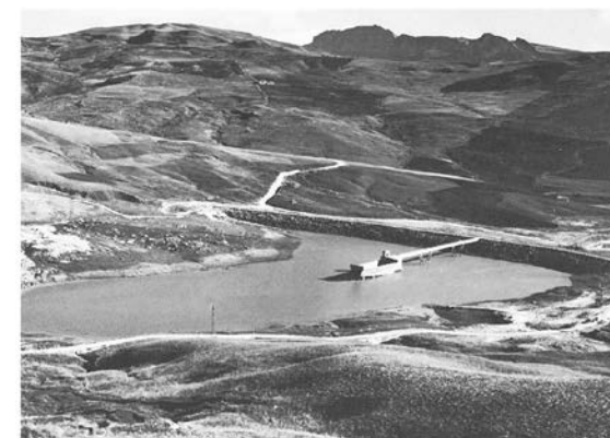
Diga di Guadalami - Veduta da monte della diga con il serbatoio parzialmente invasato; al centro del serbatoio si nota il manufatto in calcestruzzo dello scarico di superficie
