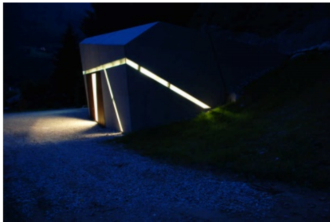
Monovolume Architecture + Design, Centrale Idroelettrica , Villetta, Italia, 2008-2009 – viste della centrale. Immagine per gentile concessione di Monovolume Architecture + Design
