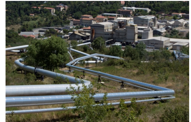
Vapordotti del Bacino di Larderello. Fonte: Archivio personale
