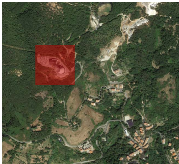
Centrale Geotermica "Carboli" ENEL a Monterotondo Marittimo (Grosseto, Toscana)
