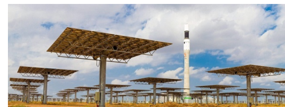
Centrale solare Gemasolar , Fuentes de Andalucía, Siviglia, 2011 – Particolare degli specchi Fonte: www.dailymail.co.uk
