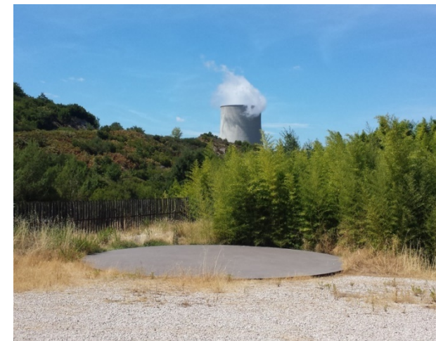
Torre di raffreddamento dell'impianto di Sasso Pisano. Fonte: Archivio personale
