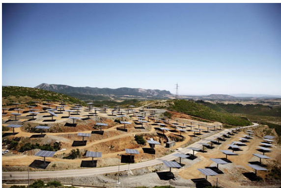
Centrale fotovoltaica di Carbonia, Sardegna, 2009 Fonte: www.arketipomagazine.it
