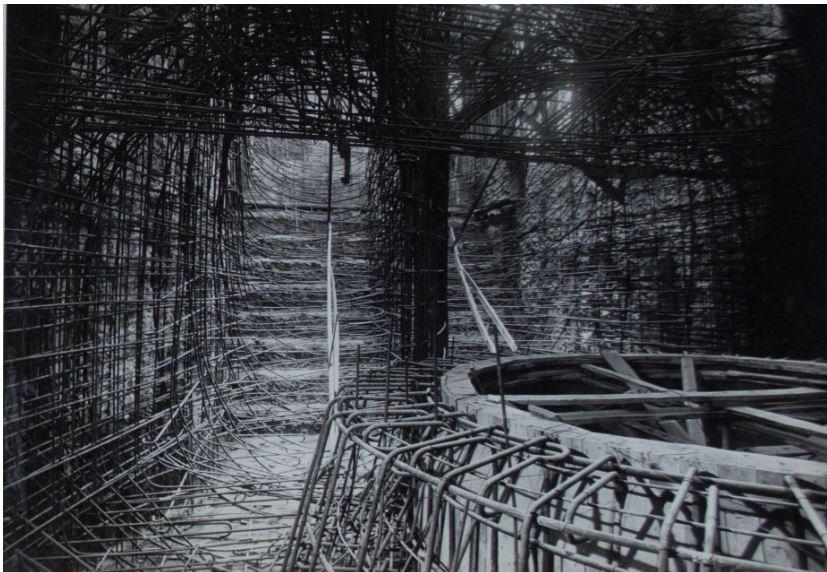
Centrale di Pontefiume – Armature in ferro prima della gettata del cemento per l'installazione del nuovo gruppo da 5000 kVA. Fonte: Archivio Storico Enel
