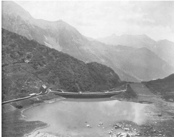
Diga di Valmorta, 1917-1923
