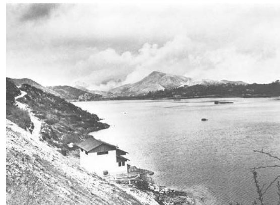
Vista del serbatoio parzialmente invaso
