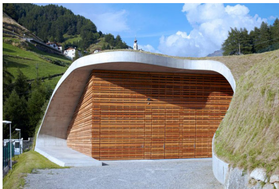
Monovolume Architecture + Design, Centrale Idroelettrica, Villetta, Italia, 2008-2009
