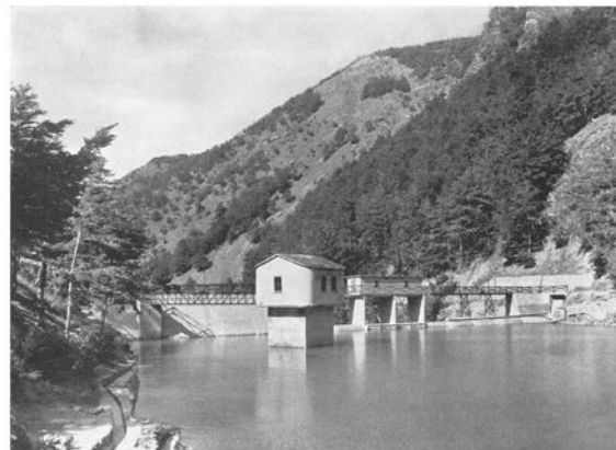
Diga di Ozola Vista da monte: in primo piano la cabina di manovra della presa e dello scarico di fondo.
