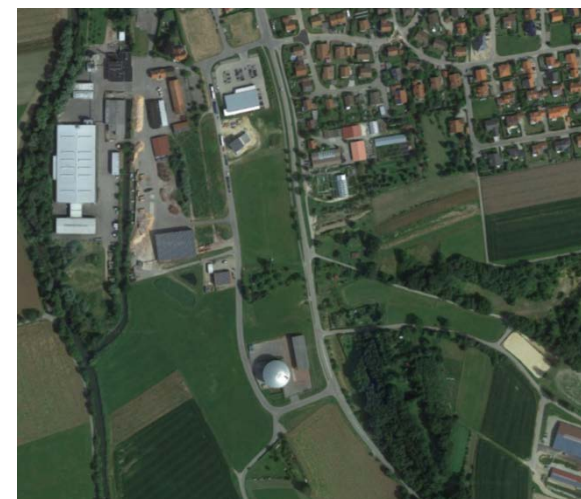
Matteo Thun & Partners, Centrale a biomasse , Schwendi, Germania, 2006-2008 - inquadramento
