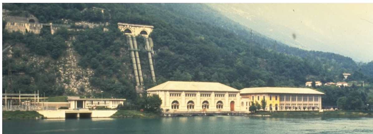
Vincenzo Ferniani, Centrale di Basso Nove, 1915 – Vista generale della centrale: in primo piano le acque del lago; sulla sinistra della centrale è visibile la stazione di trasformazione; sullo sfondo le condotte forzate che scendono dalla montagna ricoperta di boschi. Fonte: Archivio Fotografico Enelikon
