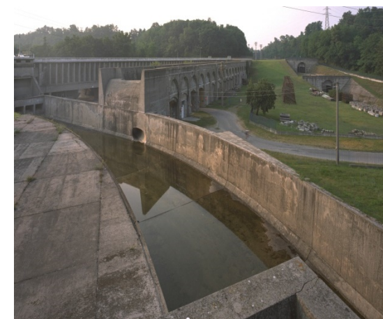
Giovanni Muzio, Centrale di Vizzola Ticino (nuova centrale), 1937 - Scorcio sul canale di scarico: "Sifone Gregotti". Fonte: Archivio Fotografico Enelikon
