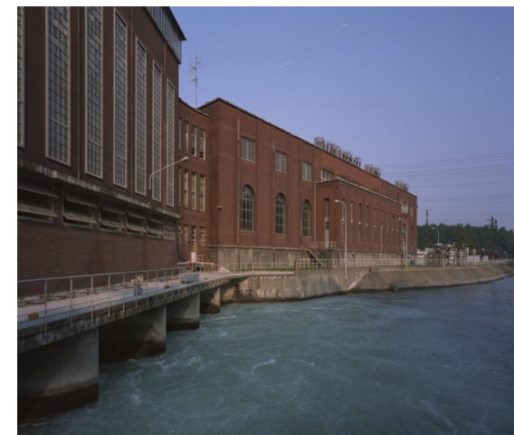
Giovanni Muzio, Centrale di Vizzola Ticino (nuova centrale), 1937 - Scorcio del lato ovest della centrale. In primo piano il canale di scarico. Fonte: Archivio Fotografico Enelikon
