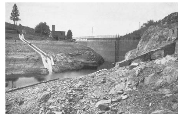
Diga del Lago Delio, 1909-1911 – Vista da monte: in sponda sinistra lo sbocco del canale di allacciamento di un affluente del Giona; a sinistra lo scarico di superficie; al centro i comandi dello scarico di fondo e della presa.
