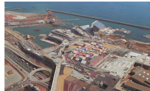
Vista del parco sud-ovest in costruzione. Si può vedere la grande copertura fotovoltaica dell'Esplanada
