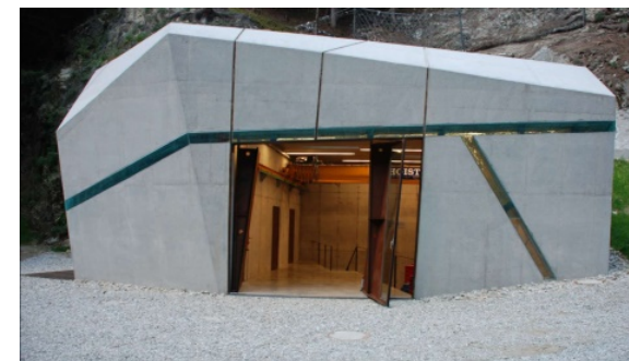
Monovolume Architecture + Design, Centrale Idroelettrica , Villetta, Italia, 2008-2009 – vista della centrale. Immagine per gentile concessione di Monovolume Architecture + Design
