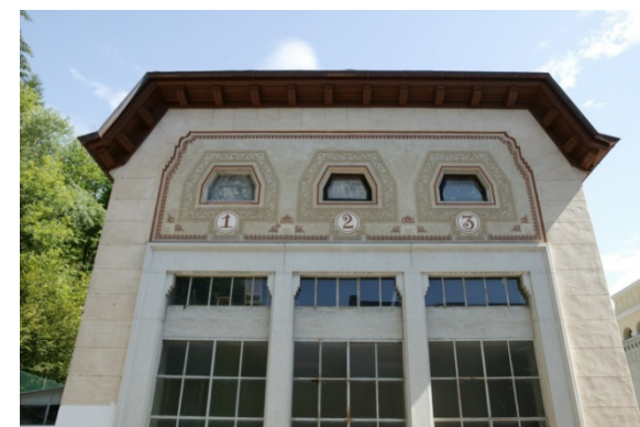
Piero Portaluppi, Centrale di Verampio, 1907 - particolare. Fonte: Archivio Fotografico Enelikon
