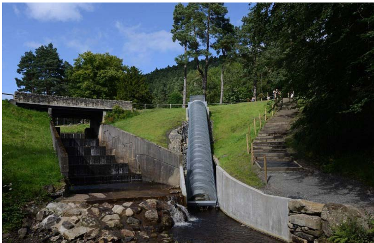
Foto della turbina "a vite di Archimede" recentemente riprodotta che servirà per alimentare l'impianto di illuminazione della casa a Cragside Fonte: www.dailymail.co.uk
