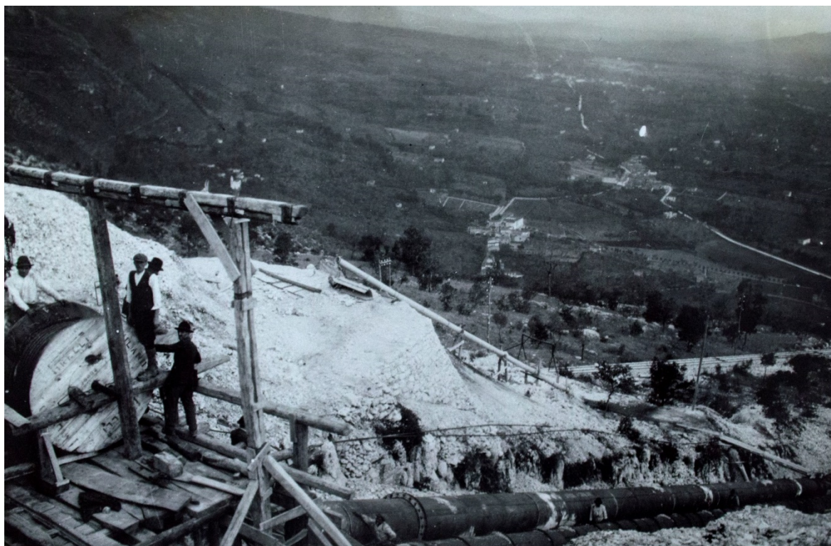
Società Meridionale di Elettricità, comparto Matese. Uomini a lavoro per la realizzazione di una condotta forzata. Fonte: Archivio Storico Enel
