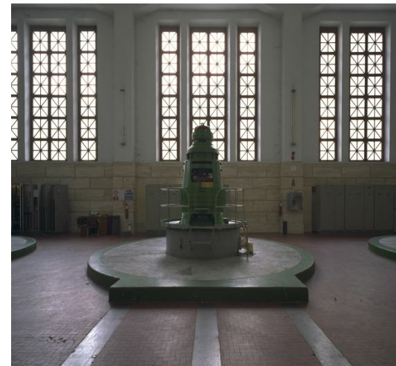
Cesare Bazzani, Centrale di Galleto, 1928 – Vista del gruppo generatore all'interno della sala macchine. Sullo sfondo le ampie vetrate della sala.
