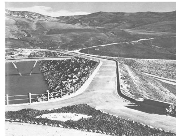
Diga di Guadalami, 1958-1960
