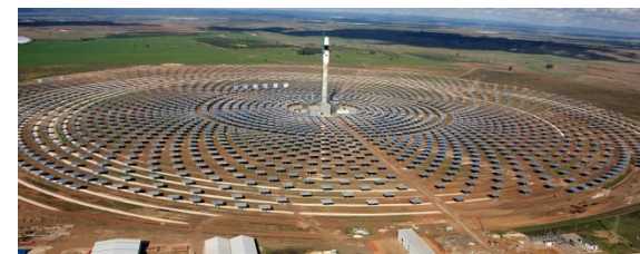
Centrale solare Gemasolar , Fuentes de Andalucía, Siviglia, 2011 – Vista dell'impianto
