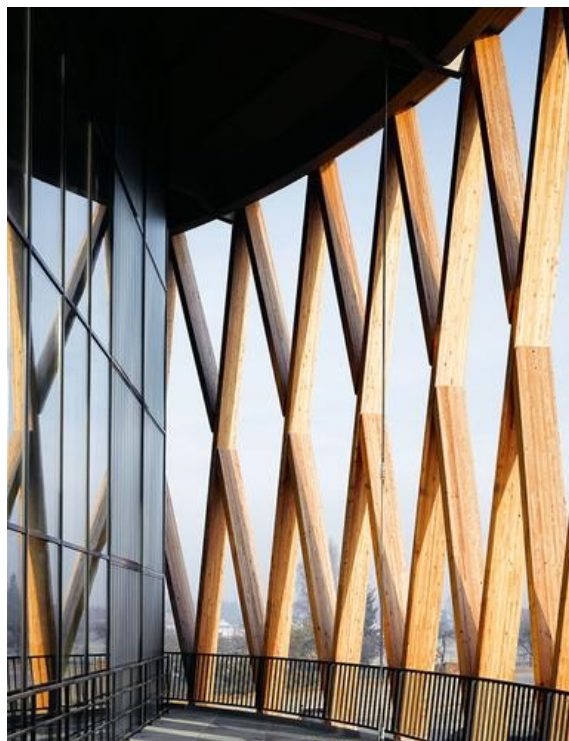
Matteo Thun & Partners, Centrale a biomasse , Schwendi, Germania, 2006-2008 - vista dell'involucro dall'interno Fonte: www.matteothun.com
