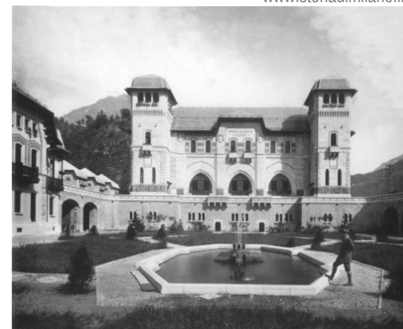
Piero Portaluppi, Centrale di Verampio, 1907 - Ettore Conti davanti alla centrale www.storiadimilano.it
