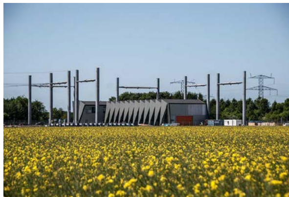
C.F. Møller, Stazione GIS, Vejle, Danimarca, 2011-2013 – viste della centrale
