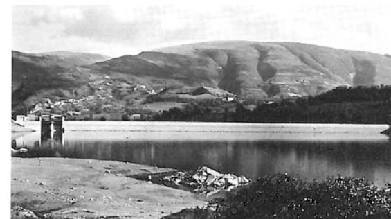
Diga di Polverina, 1963-1967 – vista da monte
