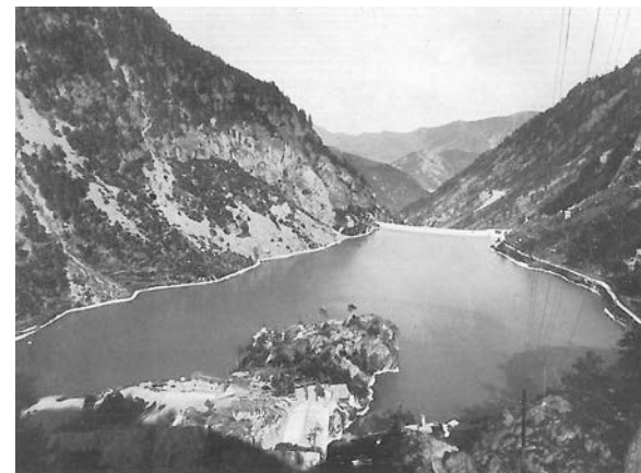
Diga delle Mesce, 1912-1917 - Vista da monte del serbatoio e della diga
