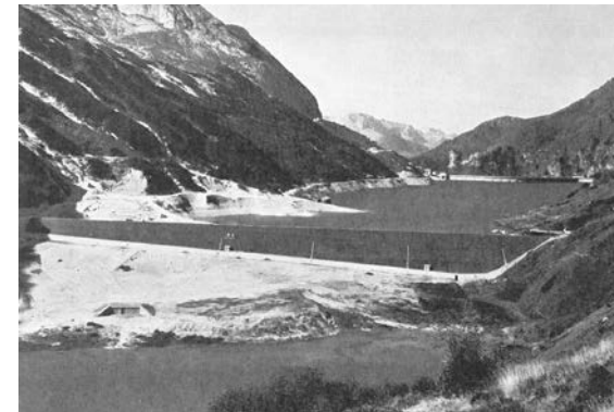
La diga vista da monte
