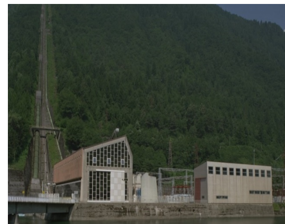
Gio Ponti, Centrale di Cimego, 1956 Scorcio della centrale. Sulla sinistra lo sviluppo della condotta forzata circondata dal bosco. In basso la sala macchine, le celle dei trasformatori, la palazzina della centrale e la stazione elettrica di trasformazione.
