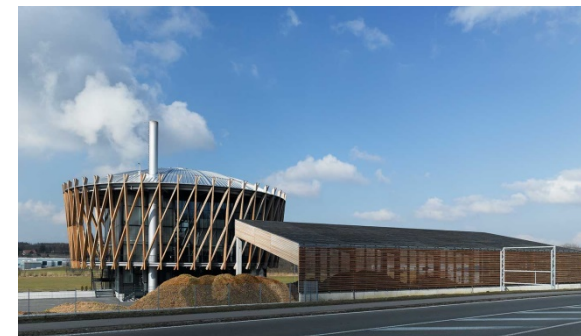
Matteo Thun & Partners, Centrale a biomasse , Schwendi, Germania, 2006-2008 - vista del padiglione posto di fronte alla centrale per lo stoccaggio delle biomasse Fonte: www.matteothun.com
