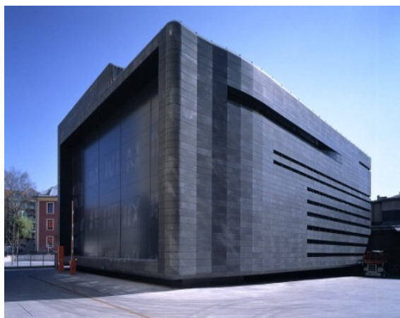
Electrical substation, Innsbruck, Austria, 1997-2002. Immagine per gentile concessione di UNStudio. Fotografia di Christian Richter
