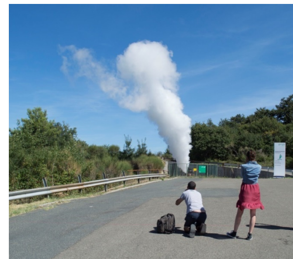
Pozzo dimostrativo di Enel Green Power, che documenta la potenza dei getti di vapore (poi convogliati nei vapordotti). Fonte: Archivio personale
