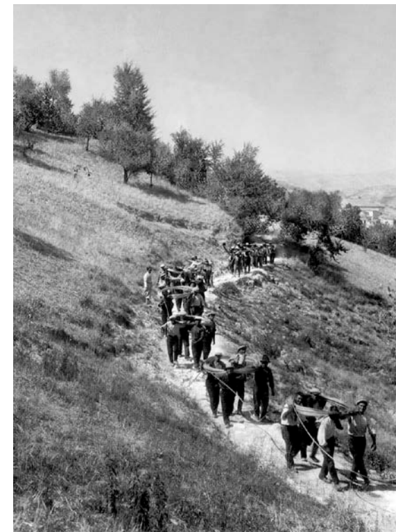
Operai a lavoro Fonte: Matteo Gerlini, Energia in Rete , Monografia dell'Archivio Storico Enel
