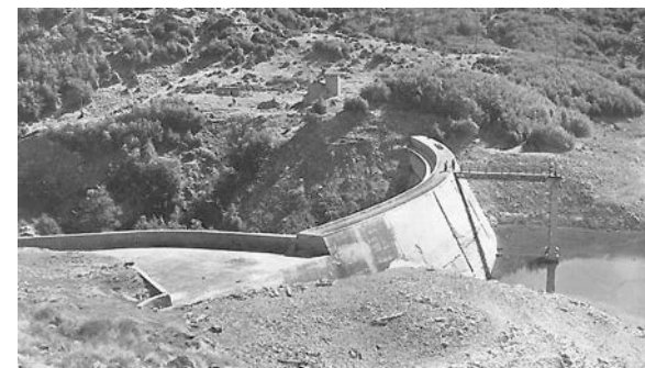
Diga del Lago Verde, 1915-1919 – Vista da monte
