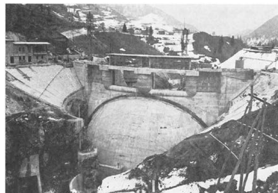
La diga vista da monte con il serbatoio vuoto: si nota la cupola sferica poggiata all'arcone superiore
