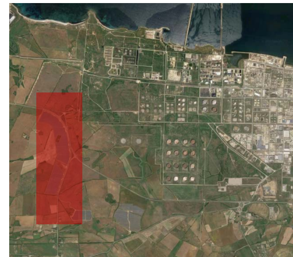
Centrale fotovoltaica a Fiume Santo (Sassari, Sardegna)
