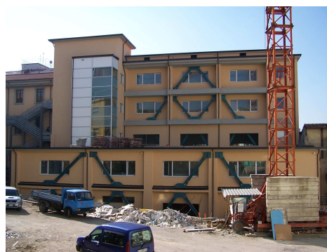
Figura 1.13: Scuola Media Busciolano (PZ), vista dell'intervento dall'esterno.
