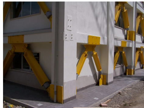
Figura 1.19: Scuola Elementare Via Lazio (PZ), vista degli ancoraggi e delle catene di piano.
