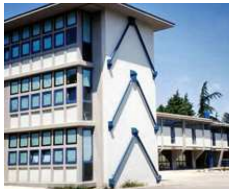
Figura 1.9: Scuola Gentile Fermi Fabriano (AN), vista dell'intervento dall'esterno.
