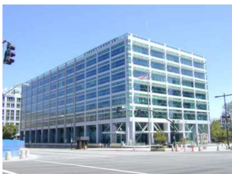
Figura 1.22: Wallace Bennett Building, vista dell'edificio.
