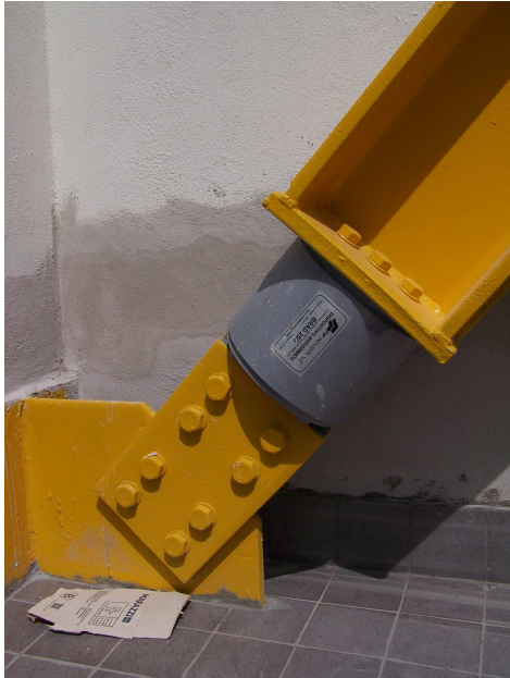
Figura 1.18: Scuola Elementare Via Lazio (PZ), particolare del dissipatore utilizzato.
