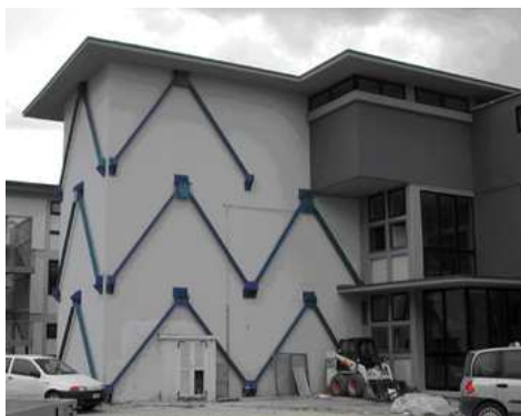
Figura 1.8: Scuola Gentile Fermi Fabriano (AN), vista dell'intervento dall'esterno.
