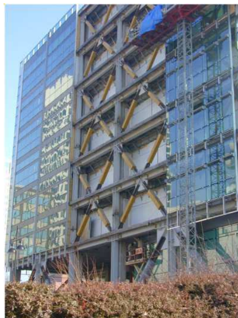
Figura 1.23: Wallace Bennett Building, vista del sistema di controventamento esterno.
