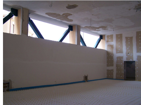
Figura 1.15: Scuola Media Busciolano (PZ), aste di controvento viste dall'interno in fase di costruzione.
