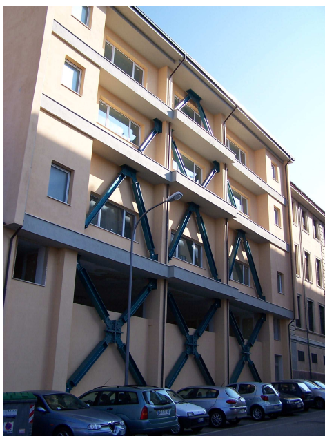
Figura 1.12: Scuola Media Busciolano (PZ), vista dell'intervento dall'esterno.
