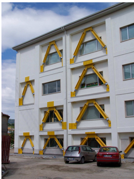
Figura 1.16: Scuola Elementare Via Lazio (PZ), vista dell'intervento dall'esterno.
