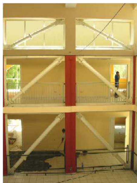
Figura 1.7: Scuola Ramacca (CT), telaio controventato, foto.
