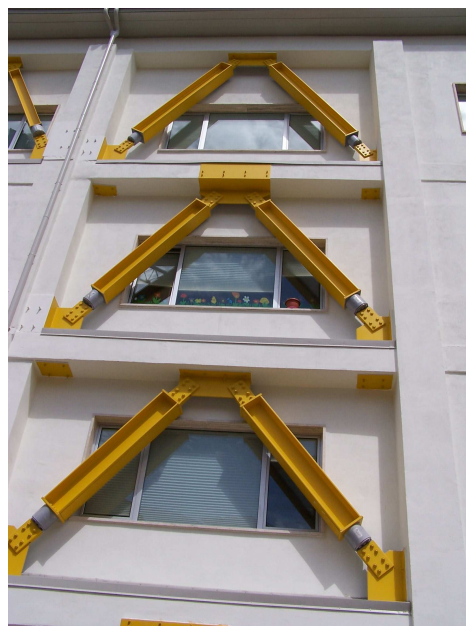
Figura 1.17: Scuola Elementare Via Lazio (PZ), vista dell'intervento dall'esterno.
