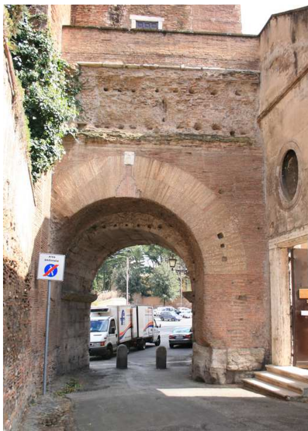
Figura 24 Arco di Dolabella e Silano, Porta Caelimontana (foto M. Dante).
