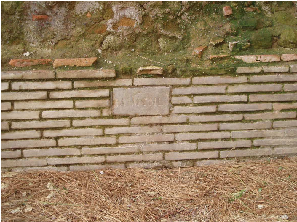
Figura 51 Targa in laterizio dei lavori di restauro degli anni 1950-1953 (foto M. Dante).
