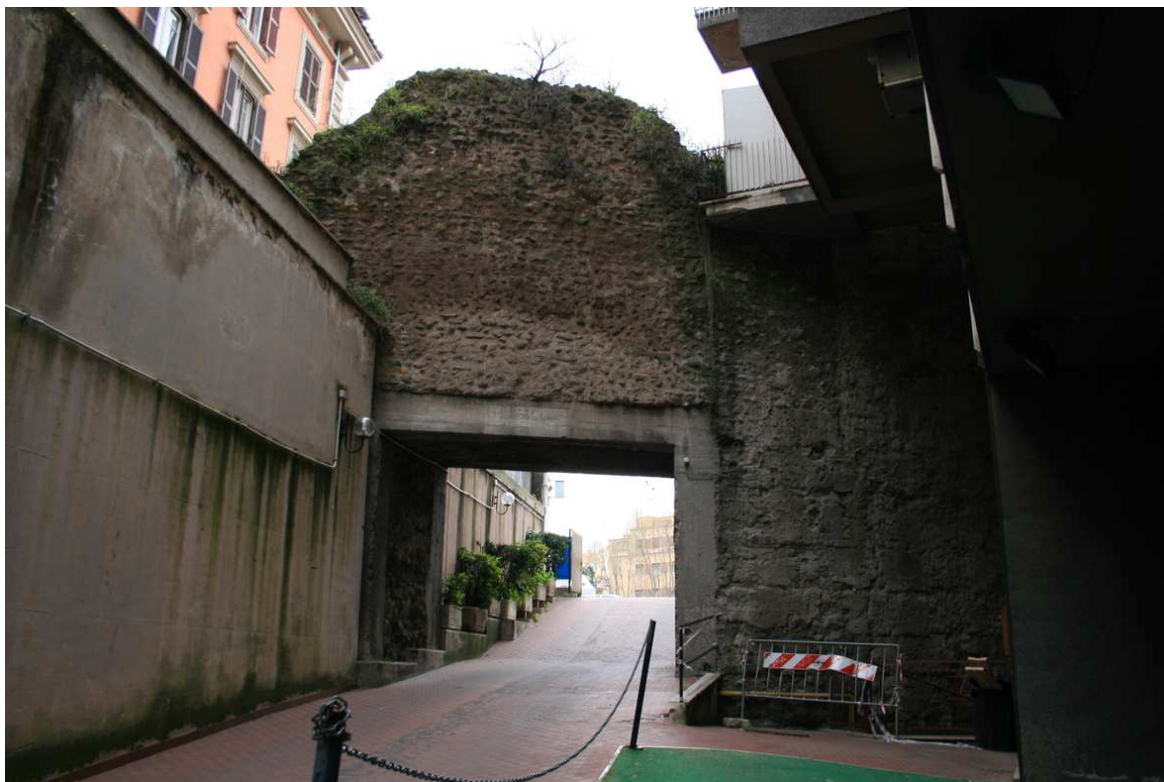
Figura 61 Varco praticato nella muratura in opus caementicium per l'accesso al piano dei garage del condominio di piazza Albania 10 (foto M. Dante).
