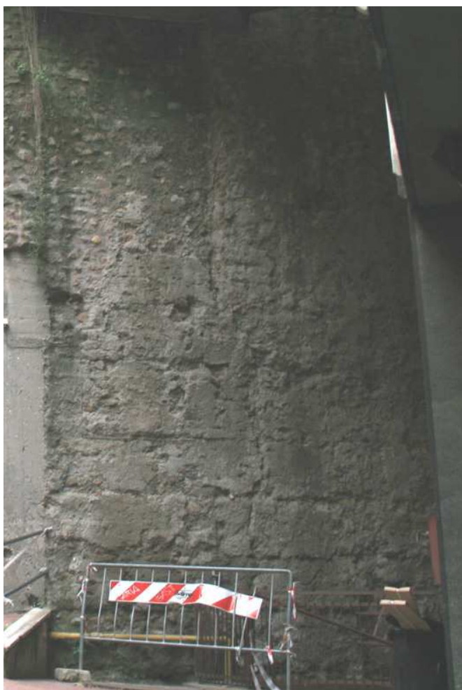
Figura 13 Particolare di opus caementicium sul retro del tratto murario fra i civici 10 e 11 in piazza Albania (foto M. Dante).
