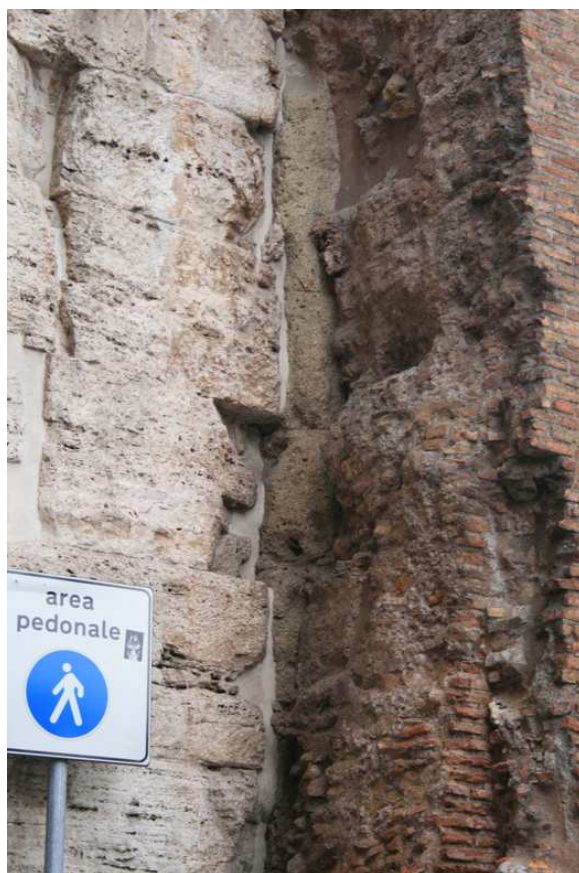
Figura 68 Particolare dell'arco di Dolabella e Silano con elementi in tufo (foto M. Dante).
