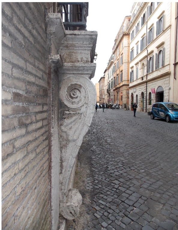
67. Roma, Palazzo Ricci-Sacchetti. Mensola reggi-davanzale di una finestra inginocchiata al piano terra (foto M. Peretti)
