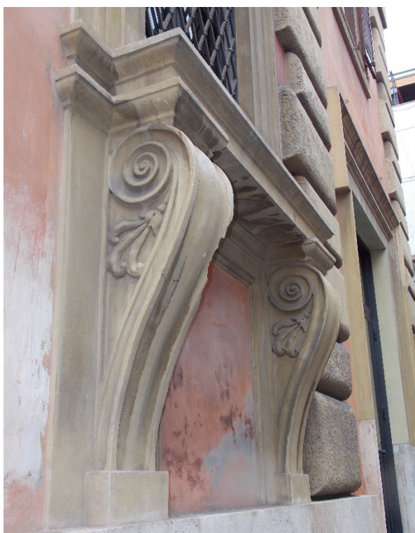
68. Roma, Palazzo Della Valle-Capranica. Mensole reggi-davanzale di una finestra inginocchiata al piano terra (foto M. Peretti)
