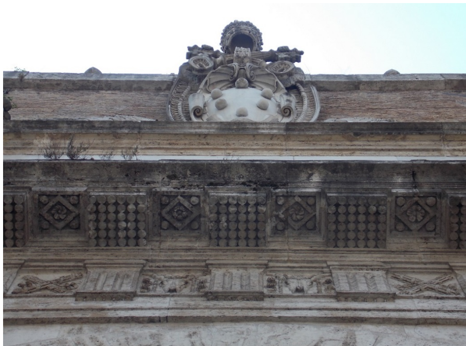
209. Roma, Porta del Popolo, dettaglio della trabeazione dorica con i mutuli sporgenti rispetto alla cornice soprastante (foto M. Peretti)
