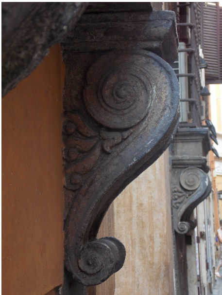
96. Roma, Palazzo Pallavicini. Mensole reggi-davanzale delle finestre inginocchiate al piano terra.
