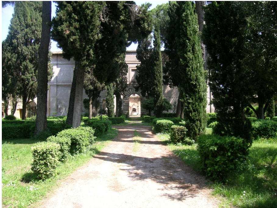
185. Roma, Casale di Pio V, vista frontale dal giardino (foto M. Peretti)
