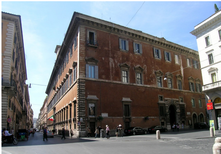
126. Roma, Palazzo Ruspoli, veduta da Largo Goldoni prima del recente restauro ( foto M. Peretti )
