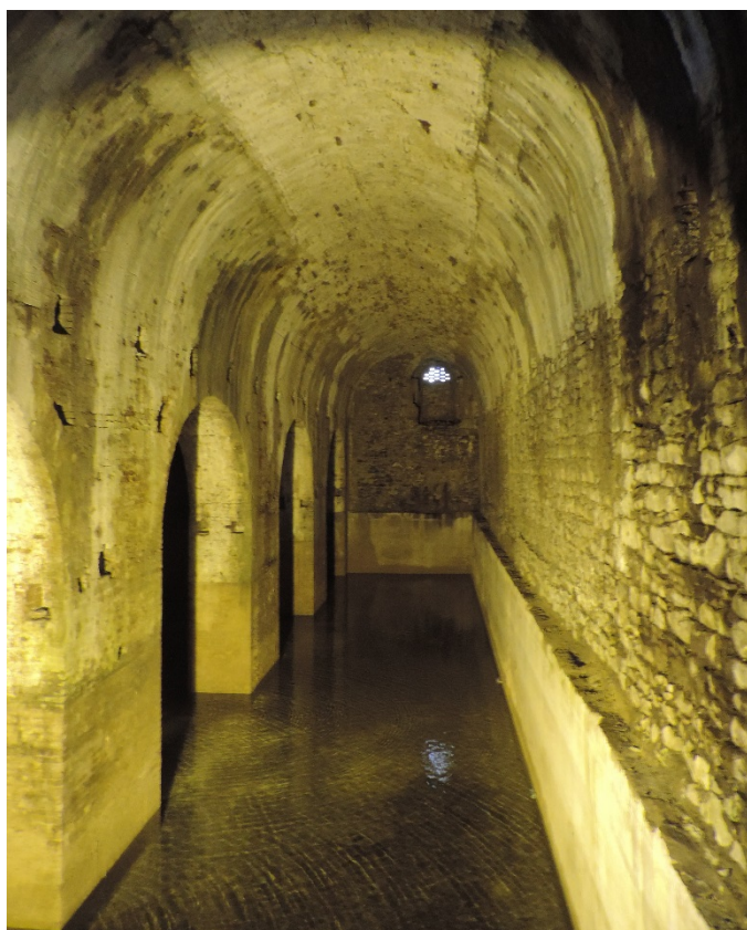
58. Monte San Savino, Palazzo Di Monte. Interno della cisterna sotto il giardino pensile, 1553-1555, Nanni di Baccio Bigio (foto M. Peretti)
