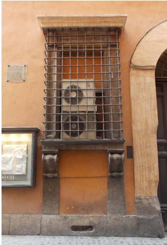
95. Roma, Palazzo Pallavicini. Finestra inginocchiata su via di Campo Marzio (foto M.Peretti)
