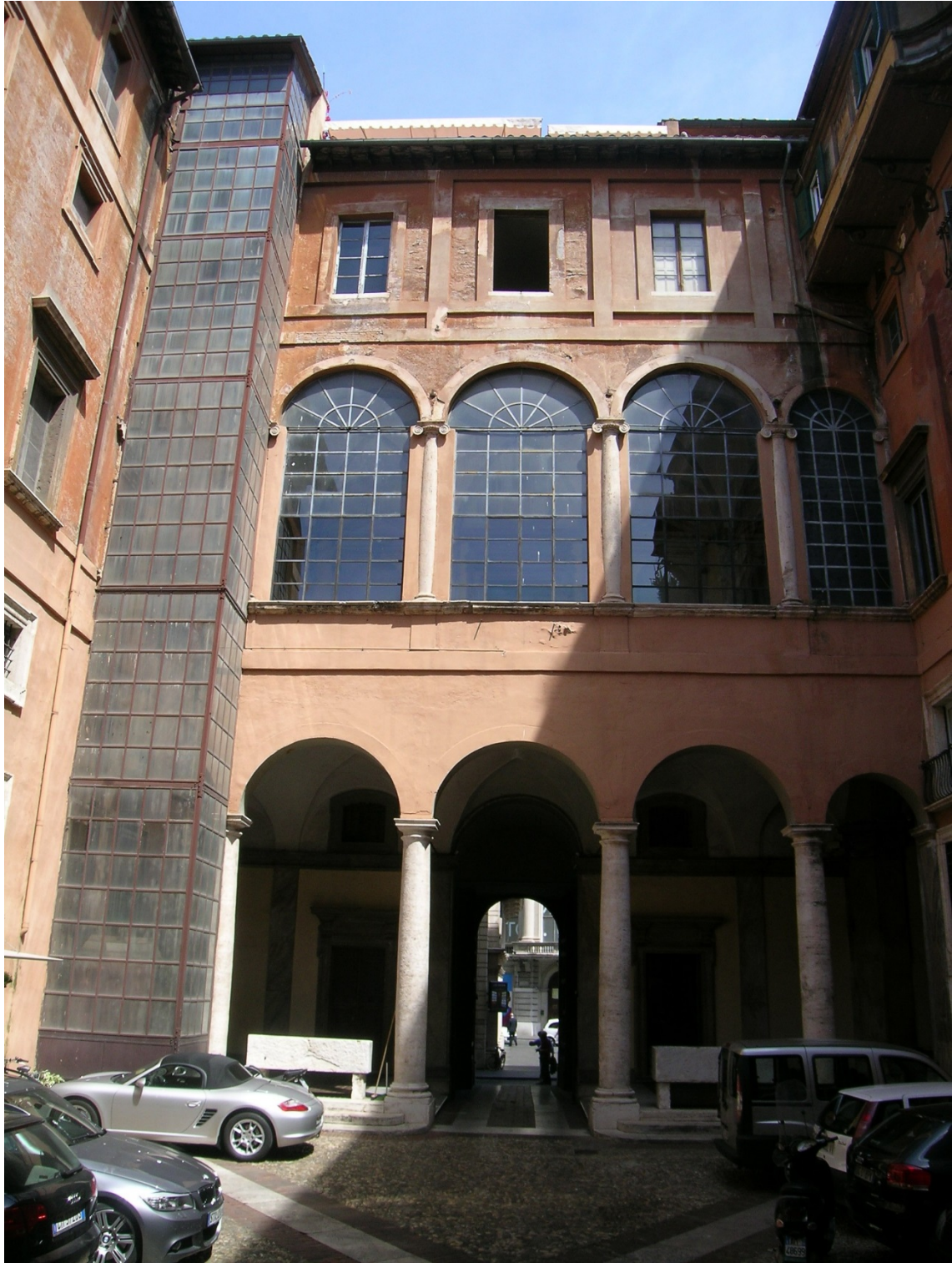
137. Roma, Palazzo Ruspoli. La controfacciata prima del recente restauro (foto M. Peretti)
