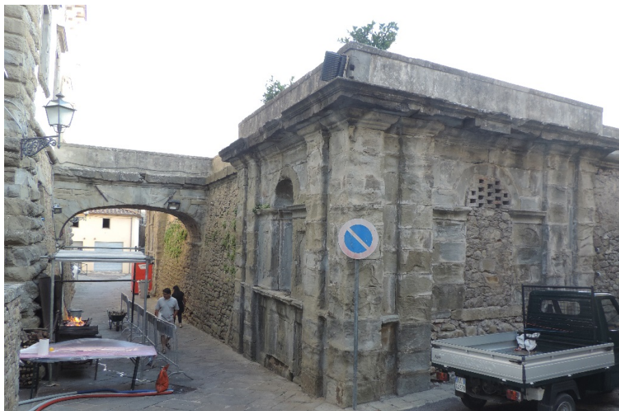
57. Monte San Savino, Palazzo Di Monte. Cisterna sotto il giardino pensile, 1553-1555, Nanni di Baccio Bigio (foto M.Peretti)
