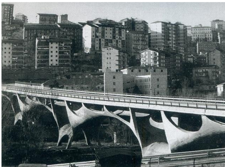
fig. 35 - Ponte sul Basento, Potenza, 1967-1975 ( Il ponte e la città. Sergio Musmeci a Potenza 2004)
