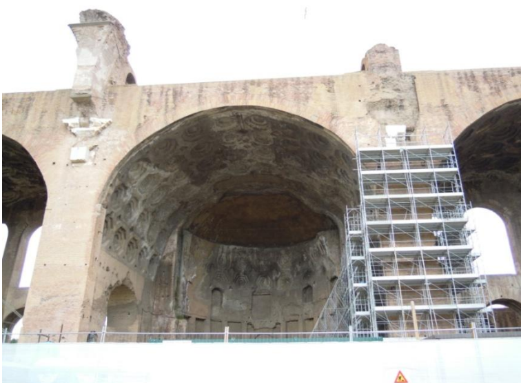
fig. 90 - Veduta interna della semicalotta oggi, Roma (foto dell'A., 2014)
