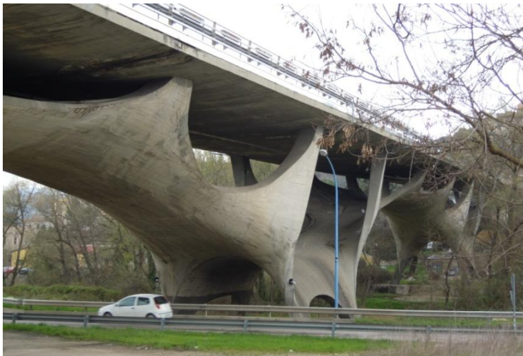
fig. 43 - Tessitura superficiale dell'intradosso della volta del ponte sul Basento, Potenza (foto dell'A., 2015)
