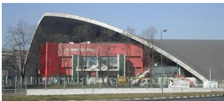
fig. 5 - F. Levi, palavela dopo l'intervento di recupero, To- rino ( http://www.italia61.it, giugno/2015 )
