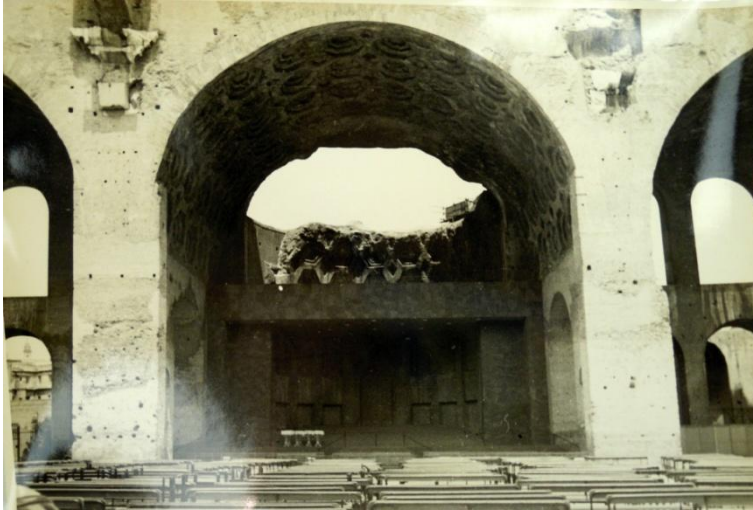
fig. 49 - L'abside costantiniana della Basilica di Massenzio, Roma, 1961 (ASMZZ, foto F009634)
