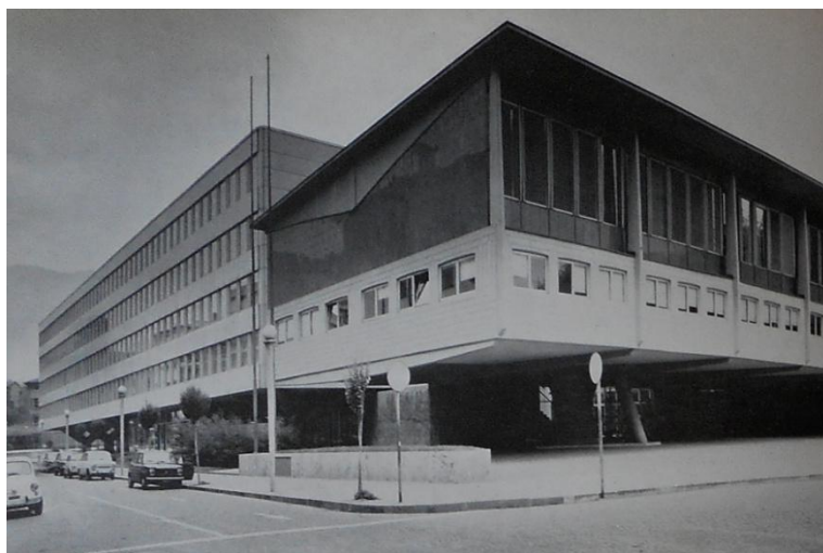
fig. 12 - Edificio della Giunta e palazzo Assessorati del palazzo della Regione, Trento, 1955-1962 (S. MUSMECI 1976)
