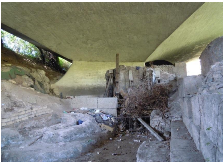
fig. 63 - Resti archeologici all'interno del viadotto, Roma (foto dell'A., 2015)
