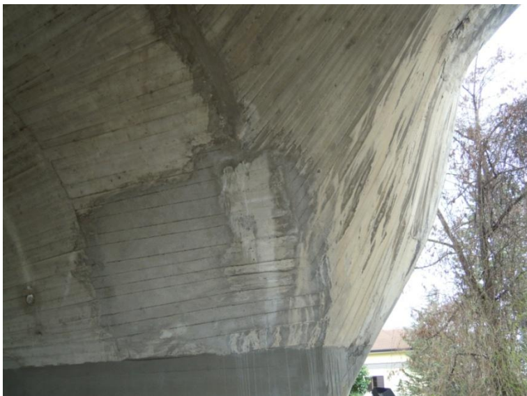
fig. 52 - Particolare di alcuni interventi di manutenzione, Potenza (foto dell'A., 2015)
