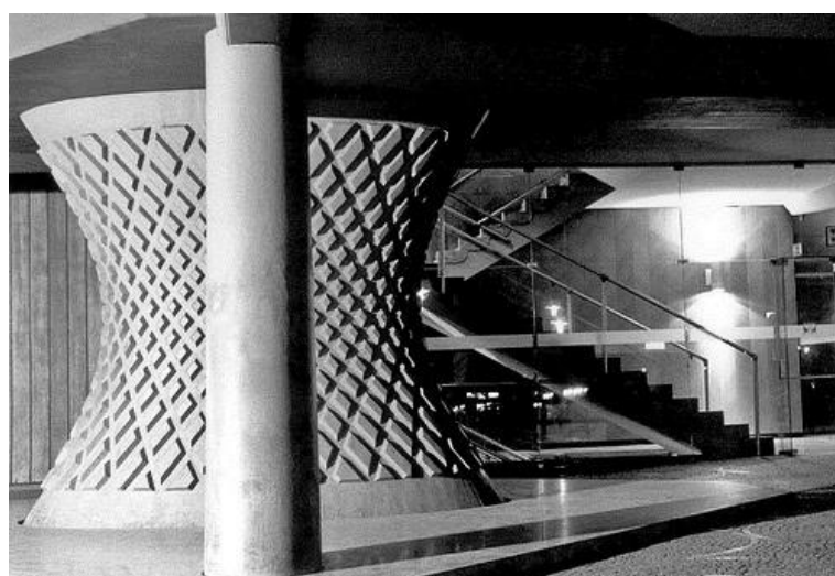
fig. 13 - Pilastro a forma di iperboloide iperbolico a sezione ellittica nell'edificio della Giunta del palazzo della Regione, Trento, 1955-1962 ( https://www.flickr.com , novembre/2013)
