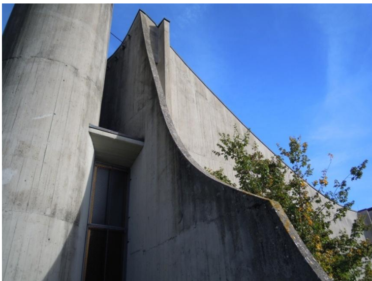
fig. 29 - Particolare dei setti in c.a. della chiesa oggi, Sarteano (foto dell'A., 2015)
