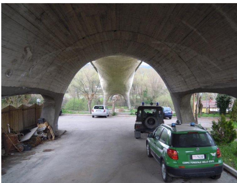
fig. 36 - Campata del ponte sul Basento dal lato di viale Marconi, Potenza (foto dell'A., 2015)
