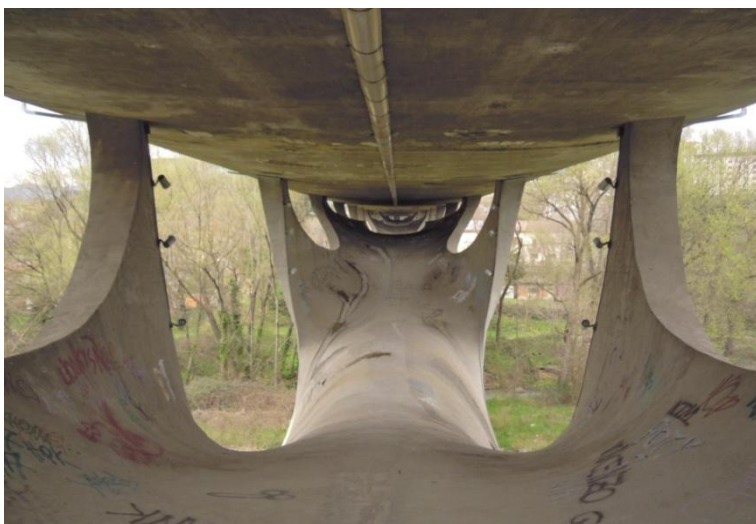
fig. 38 - Attraversamento pedonale all'interno del ponte sul Basento, Potenza (foto dell'A., 2015)
