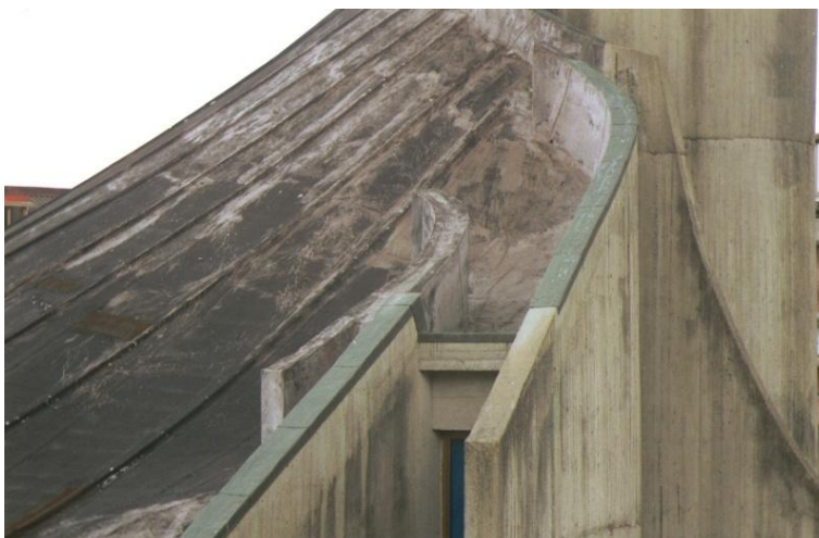
fig. 13 - Particolare della copertura della chiesa prima dell'intervento, Sarteano (foto dell'arch. F. Bardelli, 1996)
