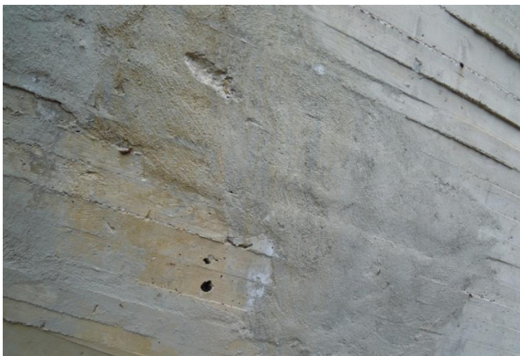
fig. 50 - Particolare di alcuni interventi di manutenzione, Potenza (foto dell'A., 2015)
