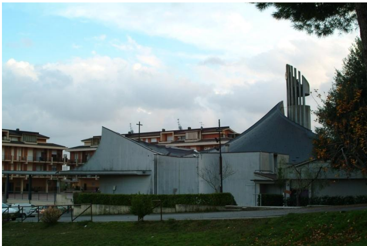
fig. 16 - Veduta esterna della chiesa di S. Alberto dopo l'intervento, Sarteano (foto dell'arch. F. Bardelli, 1996)
