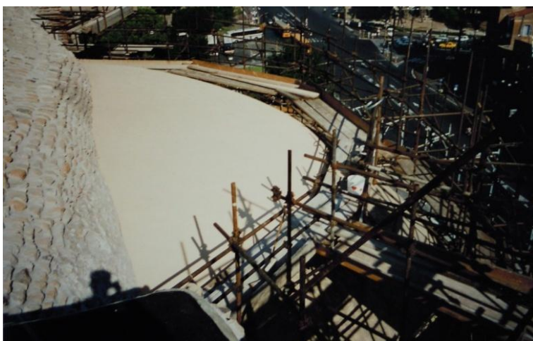
fig. 78 - La semicalotta durante i lavori, Roma (ASSBAR, Basilica di Massenzio. Manutenzione straordinaria... , 1996)
