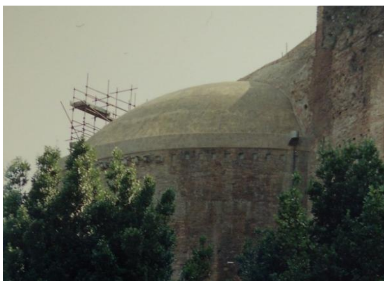
fig. 75 - La semicalotta dopo l'intervento degli anni Novanta, Roma (ASSBAR, Basilica di Massenzio. Manutenzione straordinaria... , 1996)
