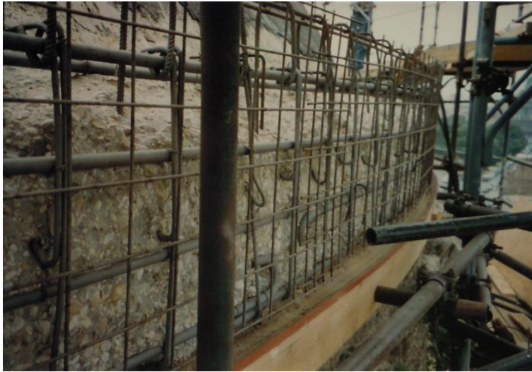
fig. 67 - Il cordolo in c.a. dopo la scarifica del copriferro e la posa delle armature di bordo; integrazione di armatura in rete per riportare la trave anulare sul filo della muratura, Roma (ASSBAR, Basilica di Massenzio. Manutenzione straordinaria... , 1996)
