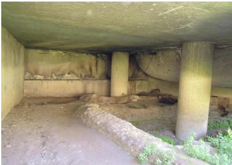
fig. 59 - Resti archeologici all'interno del viadotto, Roma (foto dell'A., 2015)
