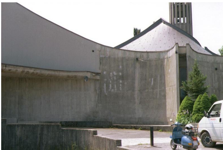
fig. 18 - Particolare di un setto in c.a. della chiesa durante i lavori, Sarteano (foto dell'arch. F. Bardelli, 1996)
