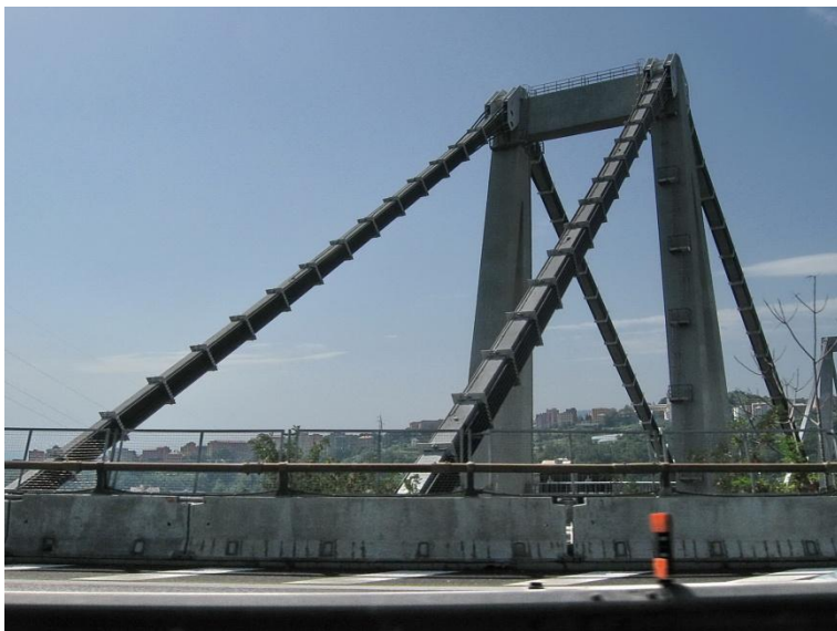
fig. 2 - R. Morandi, viadotto sul Polcevera oggi, Genova ( http://www.retrofutur.org , giugno/2015)
