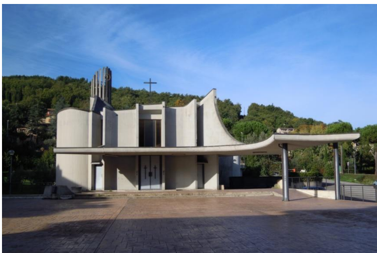
fig. 24 - Facciata principale della chiesa di S. Alberto oggi, Sarteano (foto dell'A., 2015)
