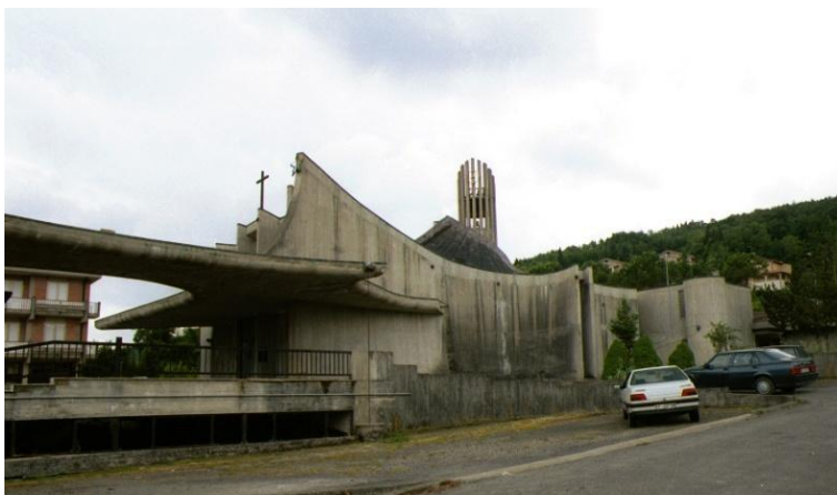
fig. 15 - Veduta esterna della chiesa di S. Alberto prima dell'intervento, Sarteano (foto dell'arch. F. Bardelli, 1996)
