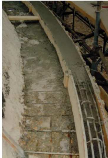
fig. 68 - Sabbatura dei ferri e della superficie del cordolo in c.a., Roma (ASSBAR, Basilica di Massenzio. Manutenzione straordinaria... , 1996)
