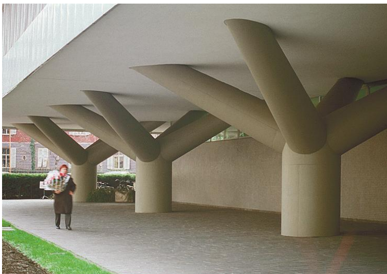
fig. 12 - S. Musmeci, pilastro ad 'albero' nel palazzo Assessorati del palazzo della Regione, Trento, 1955-1962 ( http://www.vitatrentina.it , novembre/2013)
