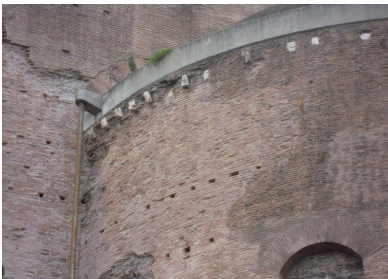
fig. 88 - Particolare del cordolo in c.a. oggi, Roma (foto dell'A., 2014)
