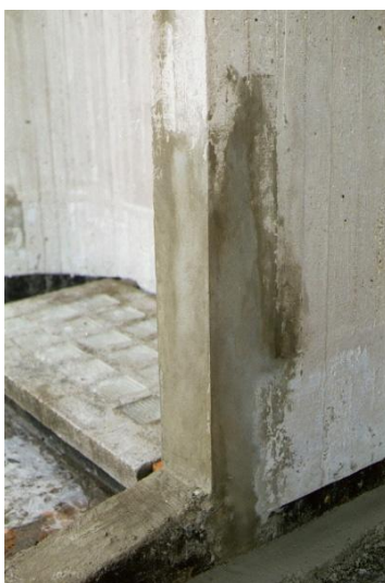
fig. 21-22 - Particolare dei setti in c.a. della chiesa durante i lavori, Sarteano (foto dell'arch. F. Bardelli, 1996)
