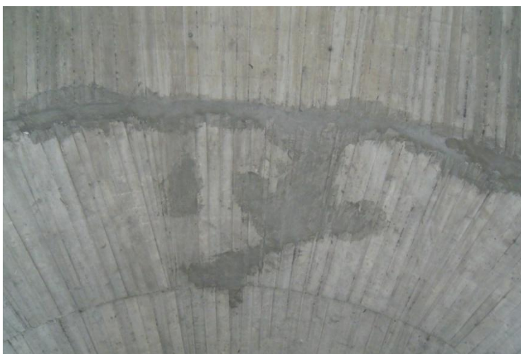
fig. 51 - Particolare di alcuni interventi di manutenzione, Potenza (foto dell'A., 2015)
