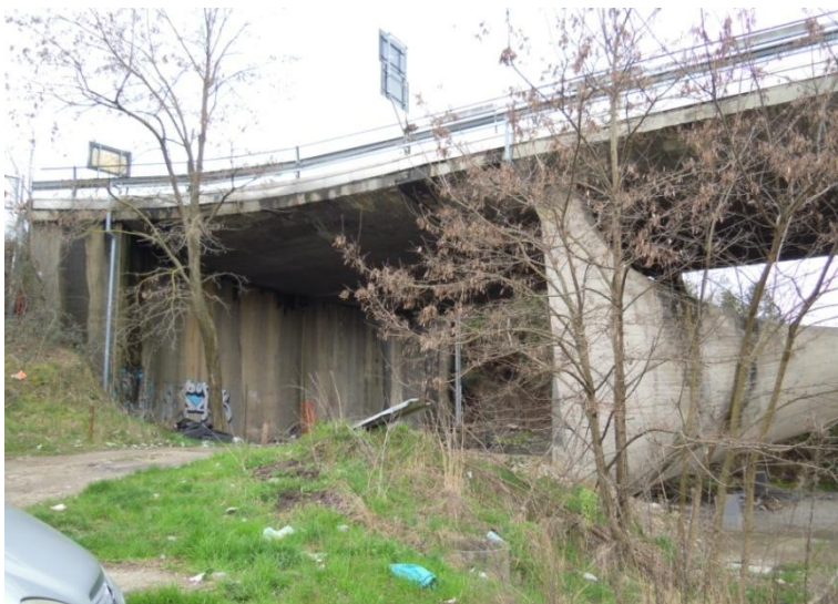
fig. 34 - Accesso pedonale all'interno del ponte sul Basento dal lato della strada statale basentana, Potenza (foto dell'A., 2015)
