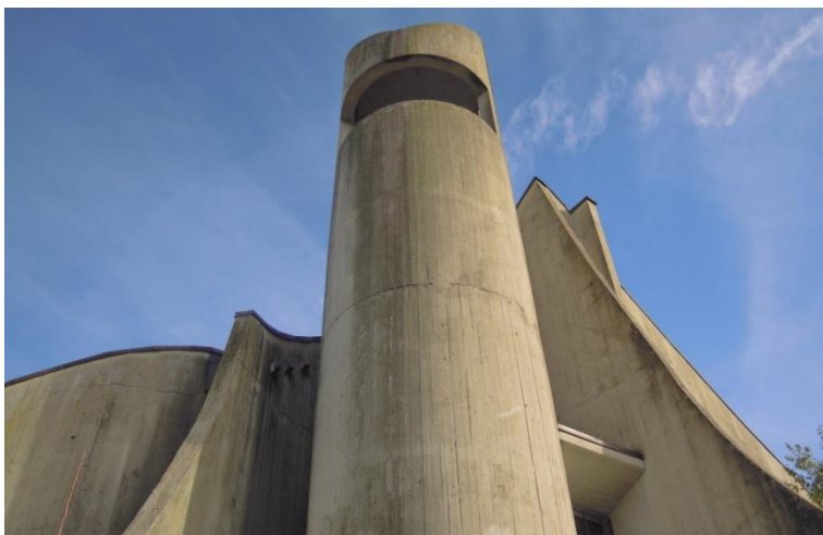
fig. 30 - Particolare del campanile e dei setti in c.a. della chiesa oggi, Sarteano (foto dell'A., 2015)
