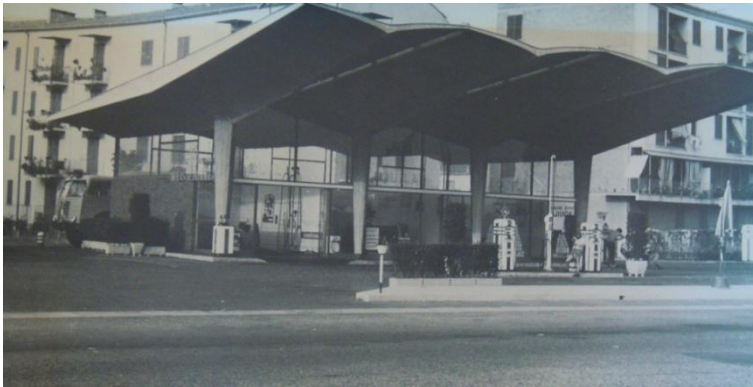
fig. 18 - S. Musmeci, stazione di servizio "Aquila", Bologna, 1958 (ASMZZ, foto F009587)
