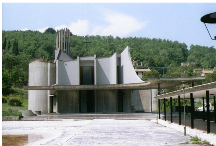
fig. 8 - Facciata principale della chiesa di S. Alberto durante i lavori, Sarteano (foto dell'arch. F. Bardelli, 1996)
