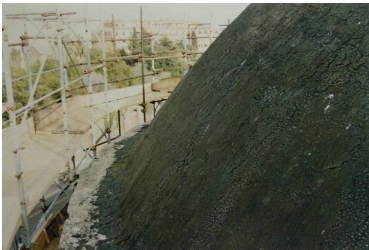
fig. 65 - Vista superiore del cordolo in c.a. alla base della semicalotta, Roma (ASSBAR, Basilica di Massenzio. Manutenzione straordinaria... , 1996)
