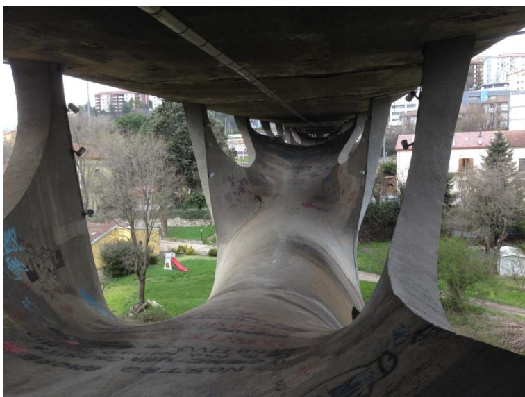
fig. 39 - Attraversamento pedonale all'interno del ponte sul Basento, Potenza (foto dell'A., 2015)
