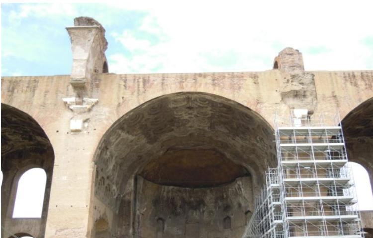
fig. 54 - Veduta interna della semicalotta per la copertura dell'abside costantiniana della Basilica di Massenzio, Roma, 1961-1962 (foto dell'A., 2014)
