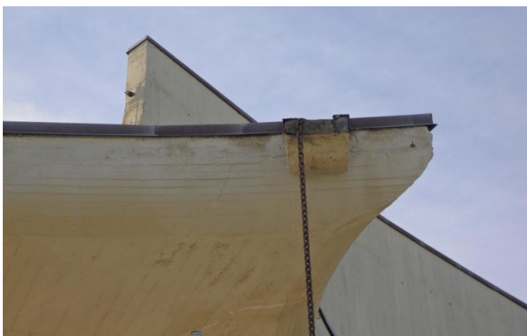
fig. 20 - Particolare del sistema di smaltimento delle acque meteoriche della chiesa oggi, Sarteano (foto dell'A., 2015)
