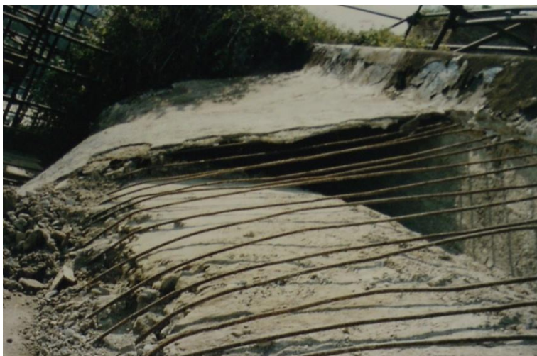
fig. 71 - La demolizione dei rinfianchi, Roma (ASSBAR, Basilica di Massenzio. Manutenzione straordinaria... , 1996)
