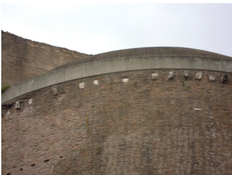
fig. 87 - Particolare del cordolo in c.a. oggi, Roma (foto dell'A., 2014)
