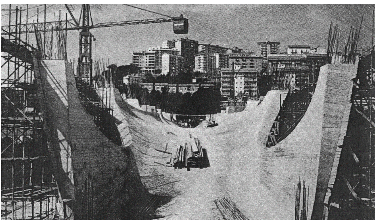
fig. 33 - La volta del ponte in costruzione, Potenza, 1967-1975 (S. MUSMECI 1977c)
