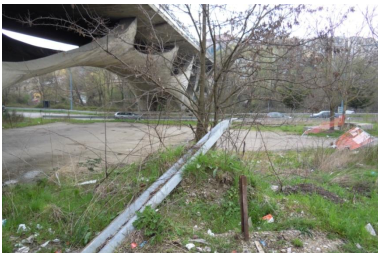
fig. 35 - Area in corrispondenza dell'accesso pedonale all'interno del ponte sul Basento, Potenza (foto dell'A., 2015)
