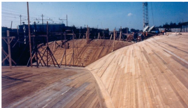
fig. 46 - Viadotto sull'Appia Antica in costruzione, Roma, 1980 (M. NICOLETTI 1999b)
