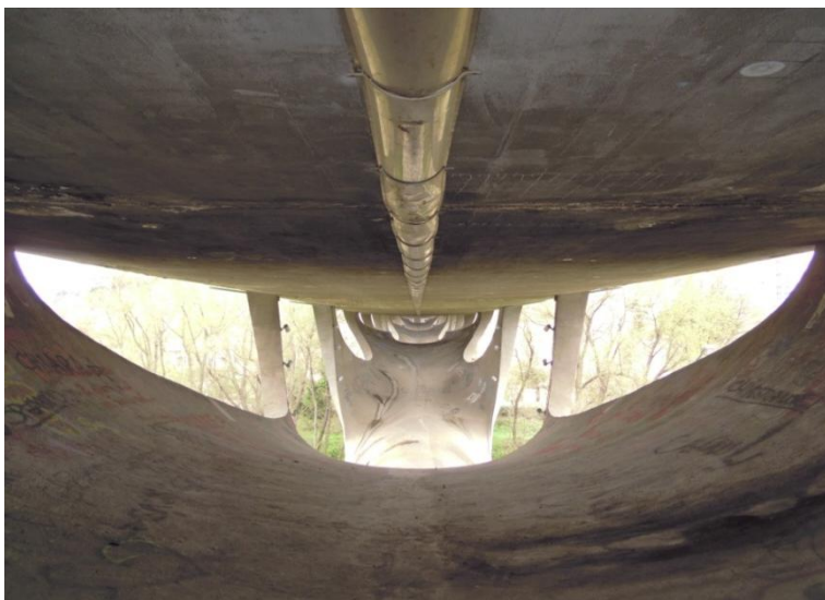
fig. 37 - Attraversamento pedonale all'interno del ponte sul Basento, Potenza (foto dell'A., 2015)
