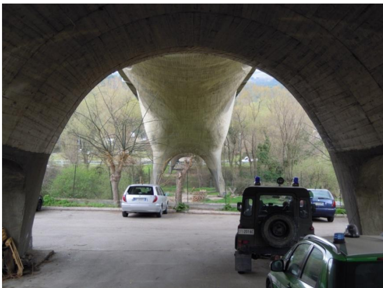
fig. 44 - Tessitura superficiale dell'intradosso della volta del ponte sul Basento, Potenza (foto dell'A., 2015)
