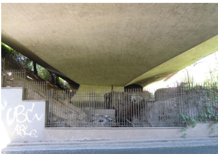
fig. 62 - Resti archeologici all'interno del viadotto, Roma (foto dell'A., 2015)
