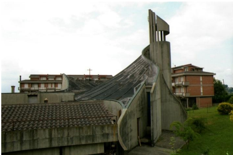
fig. 10 - Veduta esterna della chiesa di S. Alberto prima dell'intervento, Sarteano (foto dell'arch. F. Bardelli, 1996)
