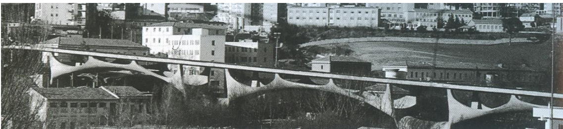
fig. 39 - Ponte sul Basento, Potenza, 1967-1975 ( Il ponte e la città. Sergio Musmeci a Potenza 2004)
