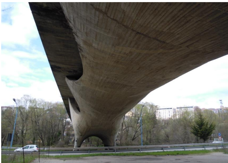
fig. 45 - Tessitura superficiale dell'intradosso della volta del ponte sul Basento, Potenza (foto dell'A., 2015)
