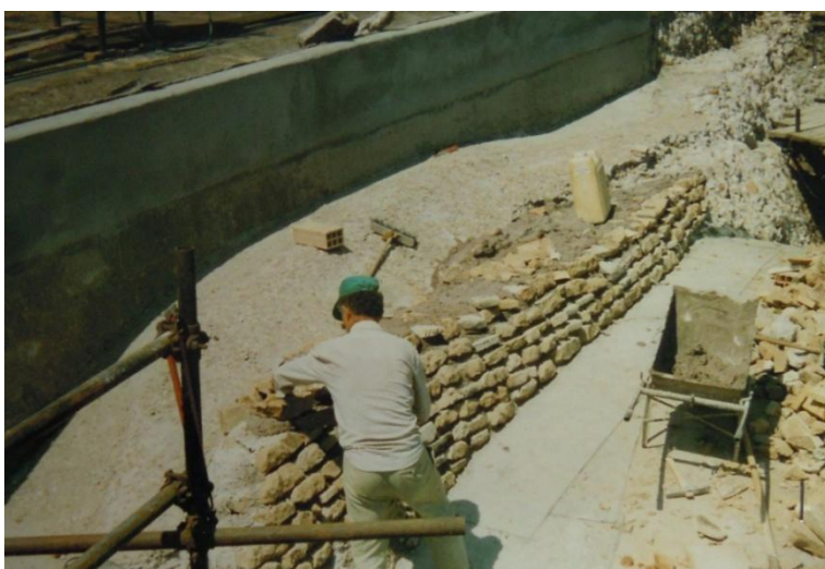
fig. 72 - Ripresa muraria sui rinfianchi, Roma (ASSBAR, Basilica di Massenzio. Manutenzione straordinaria... , 1996)
