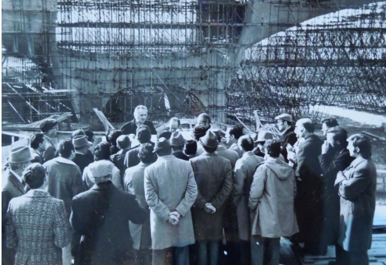
fig. 37 - La volta del ponte in costruzione, Potenza, 1967-1975 (ASMZZ, foto F18996)
