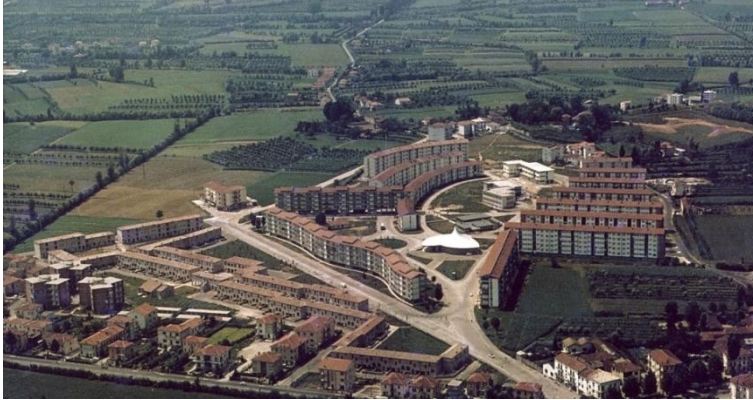
fig. 1 - Veduta del quartiere del Villaggio del Sole; al centro si nota la chiesa di S. Carlo del Villaggio del Sole, Vicenza, 1960 (A. FARESIN 2013)
