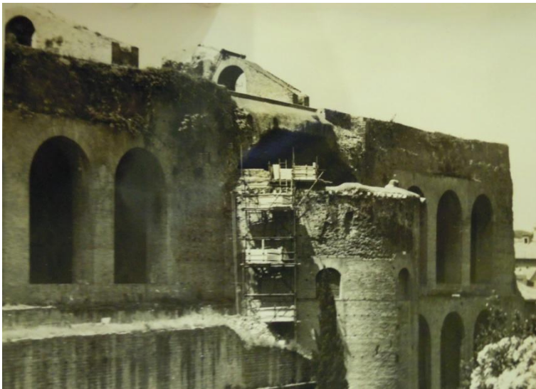
fig. 50 - L'abside costantiniana della Basilica di Massenzio, Roma, 1961 (ASMZZ, foto F009620)
