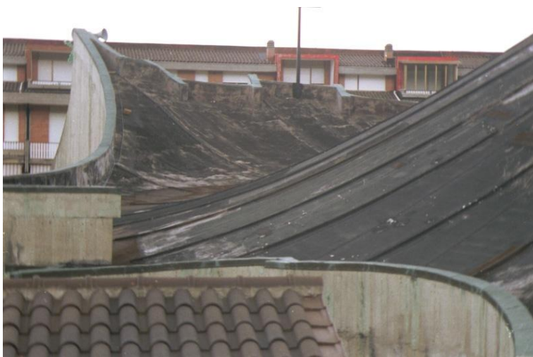
fig. 12 - Particolare della copertura della chiesa prima dell'intervento, Sarteano (foto dell'arch. F. Bardelli, 1996)
