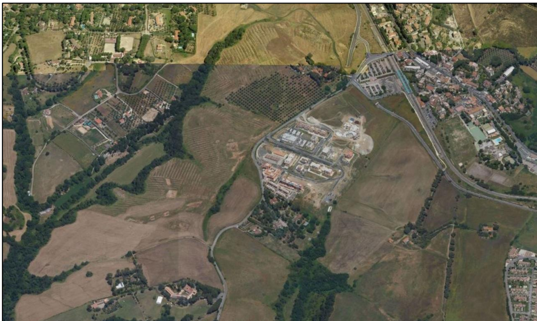
Figura 2.10 – La Storta, quartiere in costruzione in prossimità di quello esistente. Le compensazioni, talvolta, ‘atterrano’ lontano, tra i campi (Fonte: Bing Maps, 2017)
