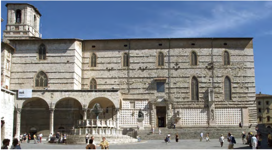
Fig. 86. Vista del prospetto laterale sinistro del duomo di S. Lorenzo a Perugia. Fotografia E. Scopinaro 2016.
