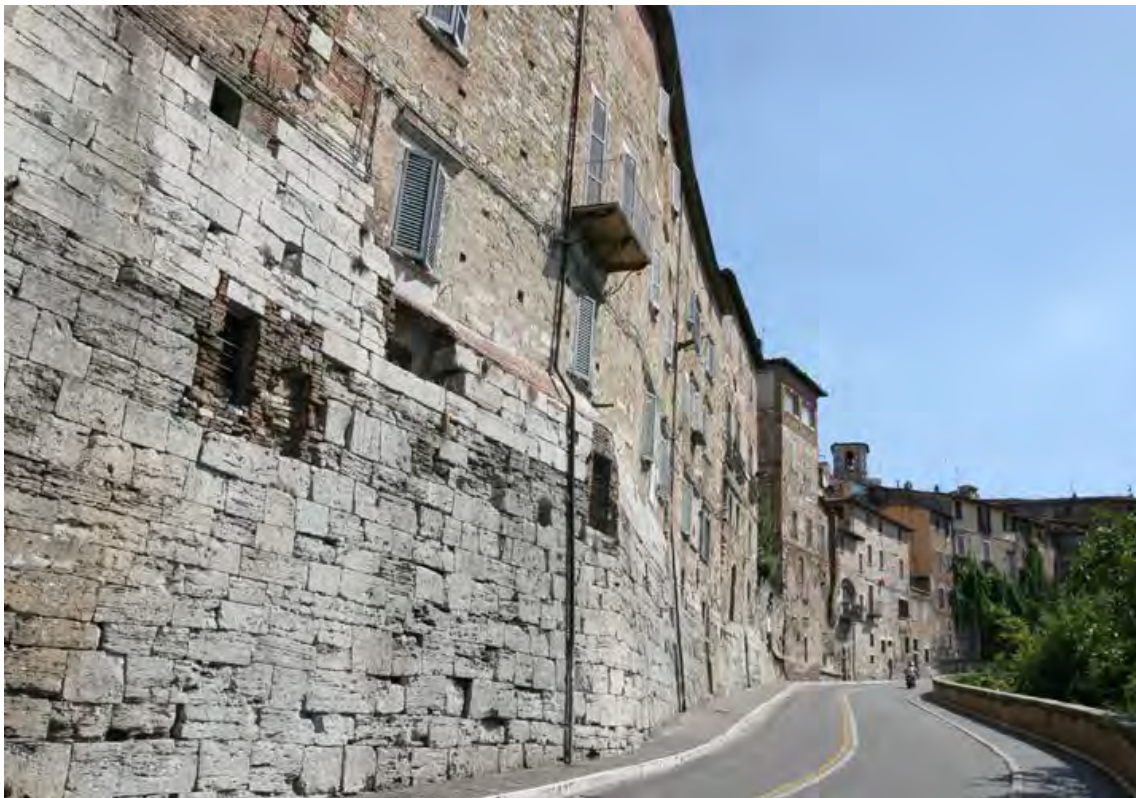
Fig. 65. Tratto delle mura etrusche della città di Perugia. Fotografia E. Scopinaro 2016.
