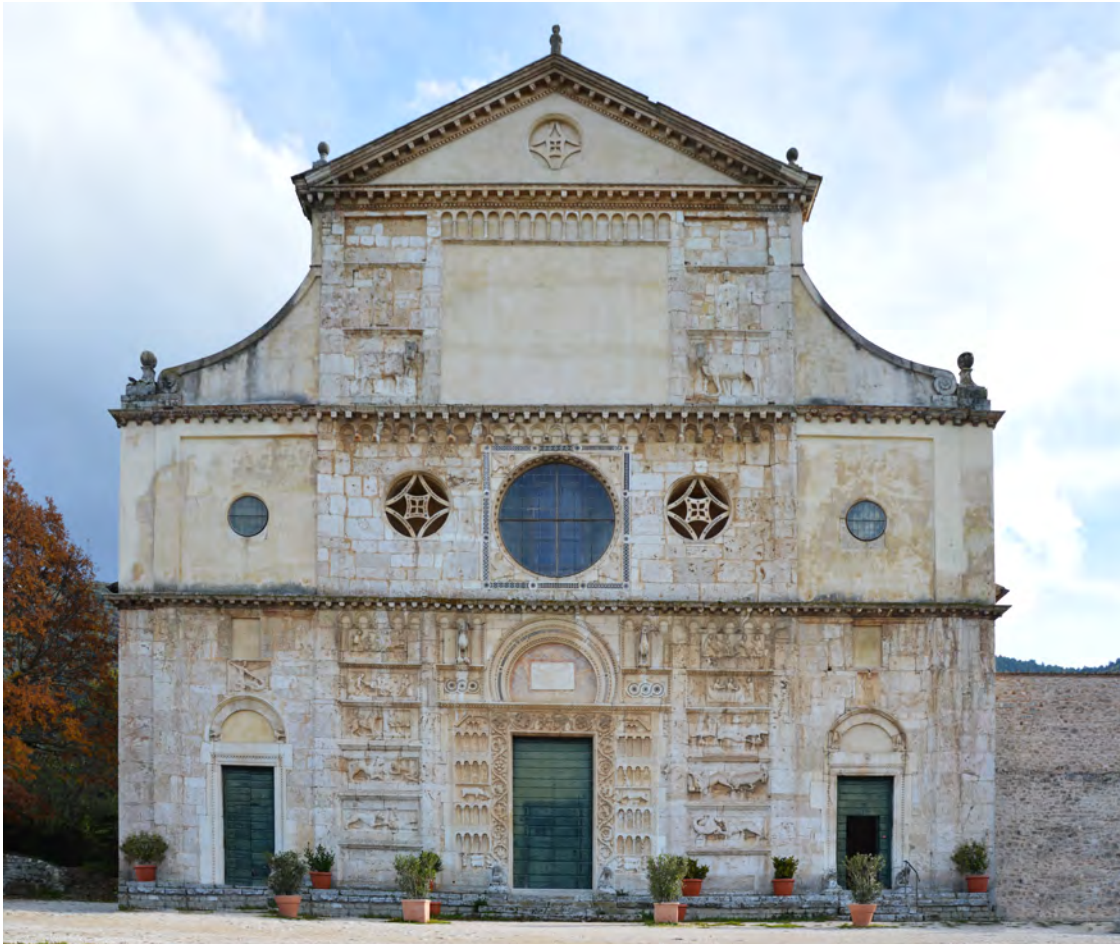
Fig. 19. La chiesa di S. Pietro a Spoleto. Fotografia E. Scopinaro 2017.
