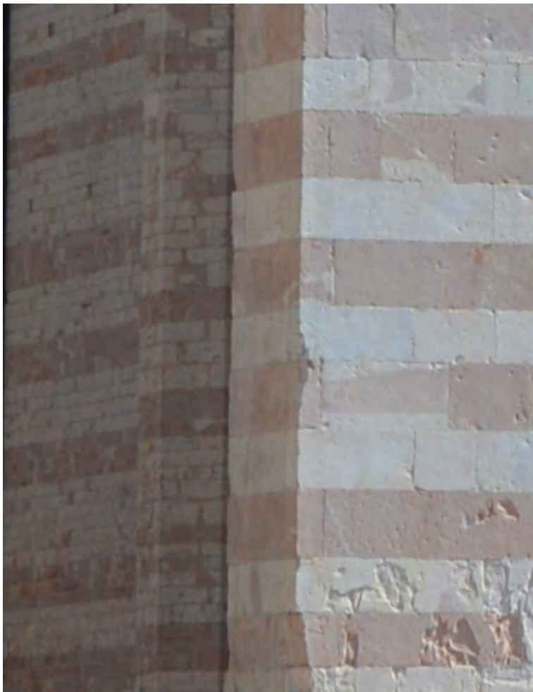
Fig. 96. a. La chiesa di S. Chiara di Assisi. b. Particolare dell'attacco tra la muratura del fianco e quella della facciata. Fotografia E. Scopinaro 2017.
