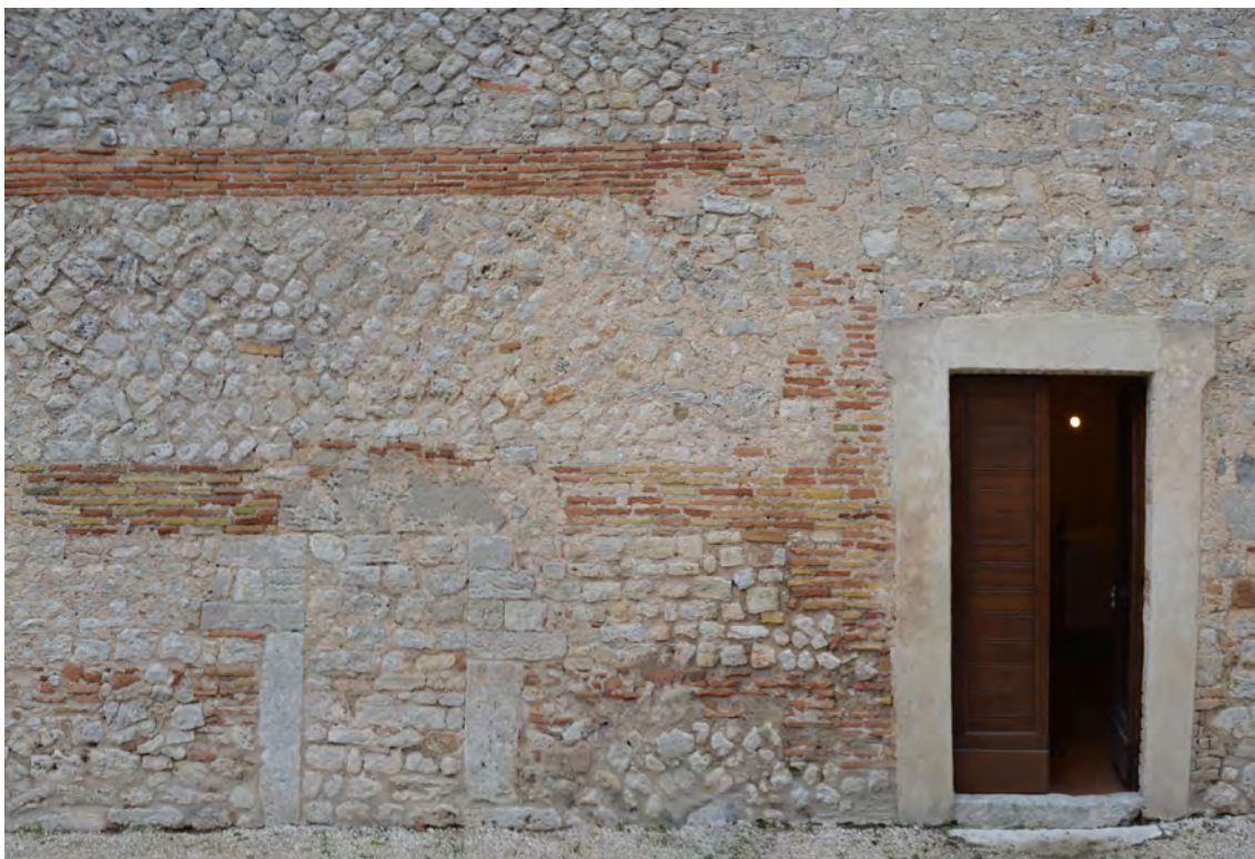
Fig. 73. Muratura del fianco destro della chiesa di S. Maria in Pantano. La porzione in basso, realizzata tra il X e l'XI secolo sembra voler riproporre la diversa posa in opera in fasce secondo l'esempio romano. Fotografia E. Scopinaro 2017.
