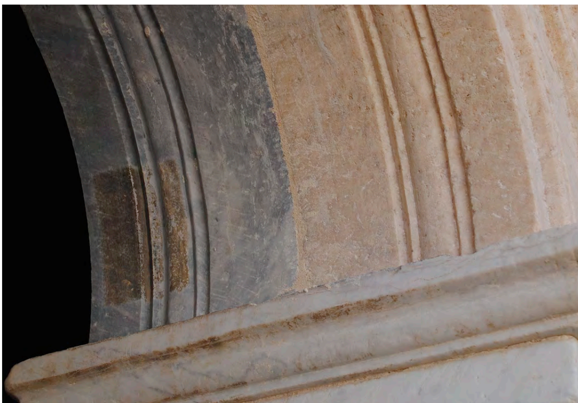
Fig. 118. Chiostro dell'abbazia di S. Croce in Sassovivo. Dettaglio del tassello di pulitura lasciato sulla prima arcata da destra del fronte ovest. Fotografia E. Scopinaro 2014.
