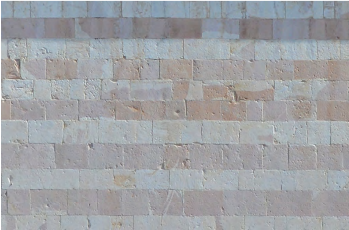
Fig. 108. La chiesa di S. Chiara ad Assisi. Particolare della muratura della facciata. Fotografia E. Scopinaro 2016.
